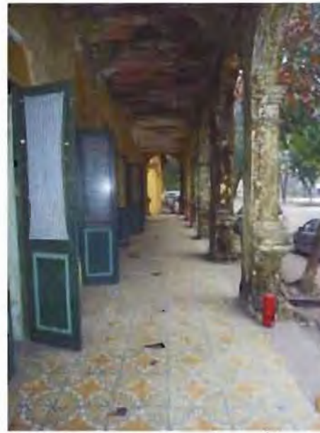
Sol en carreaux de béton
