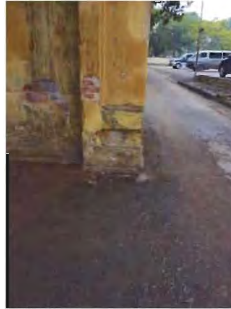
Détail socle – niveaux d'origine
