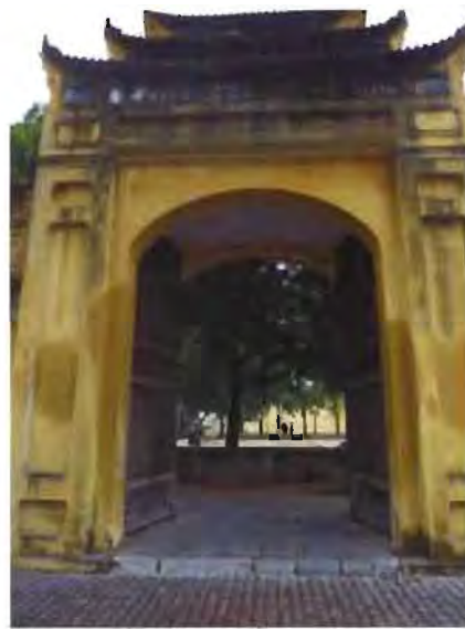
Façade Sud, porte principale
