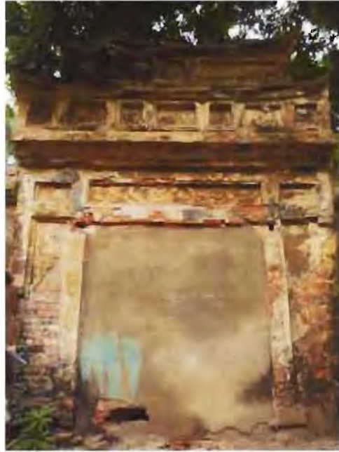
Détail façade Sud
