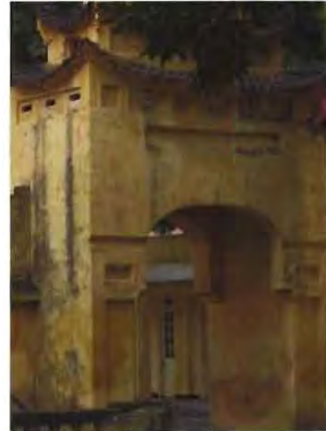
Angle sud - ouest
