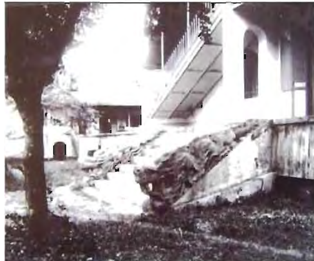
Escaliers de la Citadelle, axe sur façade Nord du socle du palais, puis bâtiment 32 - 1907
