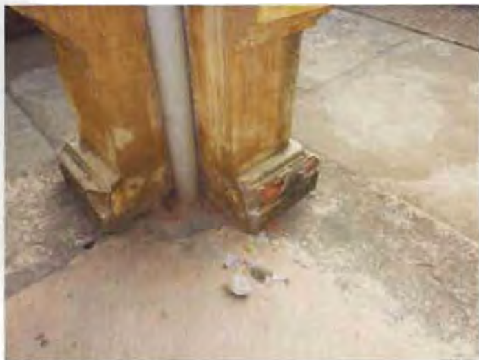
EP traversant le soubassement
