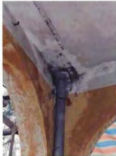
Descente d'eau pluviale
