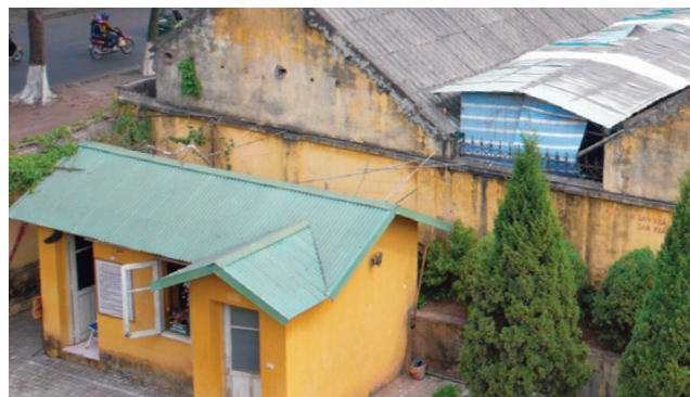
Ph. 29 Bâtiment d'accueil de la porte Nord
