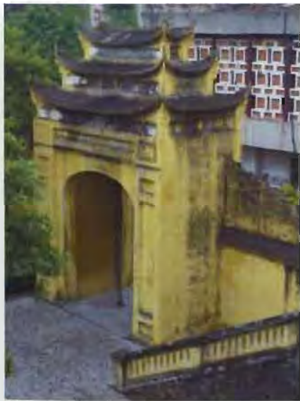
Façade Sud, porte principale
