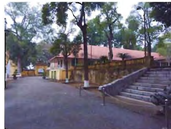
Escalier impérial et bâtiment 33
