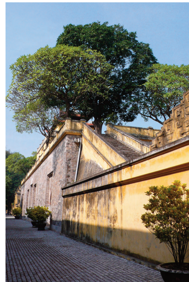
Ph. 55 La porte Sud, vue d'ensemble
