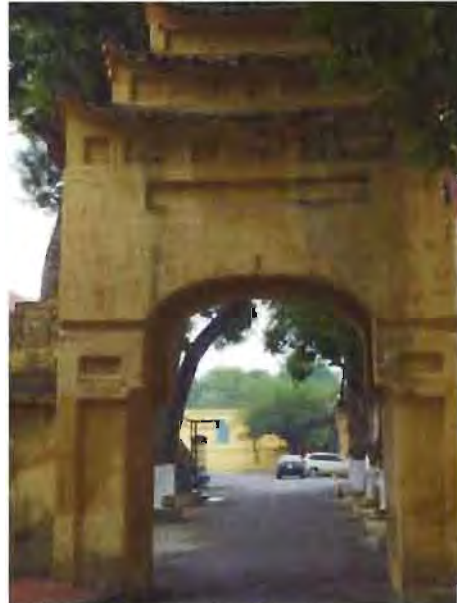
Détail façade Sud
