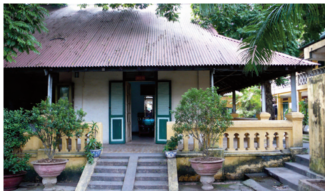
Ph. 36 Le bâtiment des officiers, façade Est
