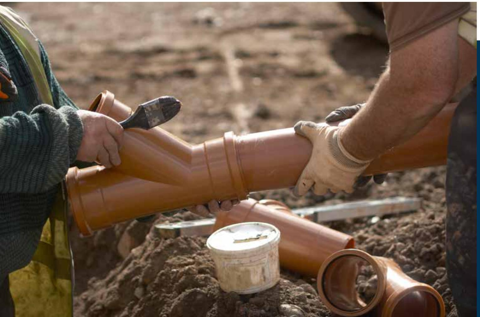
Trabajador de la construcción durante la puesta en obra de una tubería de alcantarillado
