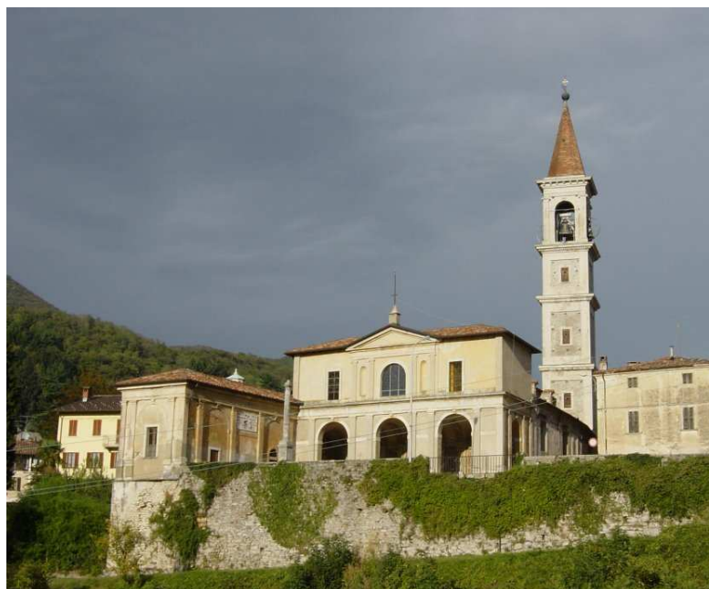
Fig. 2.27 Santo Stefano Church in Viggiù built with Pietra di Viggiù. (Photo M. Felber)
