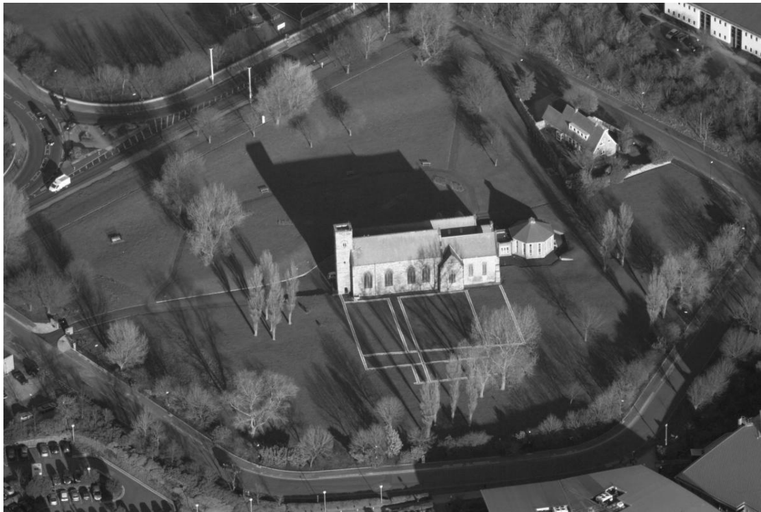
Vue aérienne de l'ensemble Saint-Pierre
