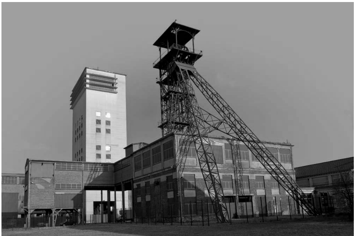
Vue d'ensemble de la fosse n°11-19 de la Compagnie des Mines de Lens
