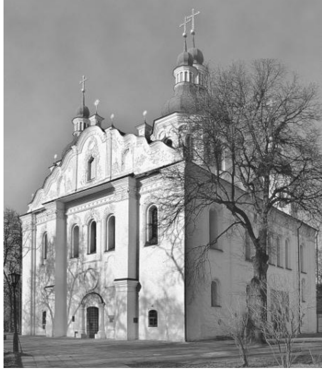
Église Saint-Cyril – vue générale
