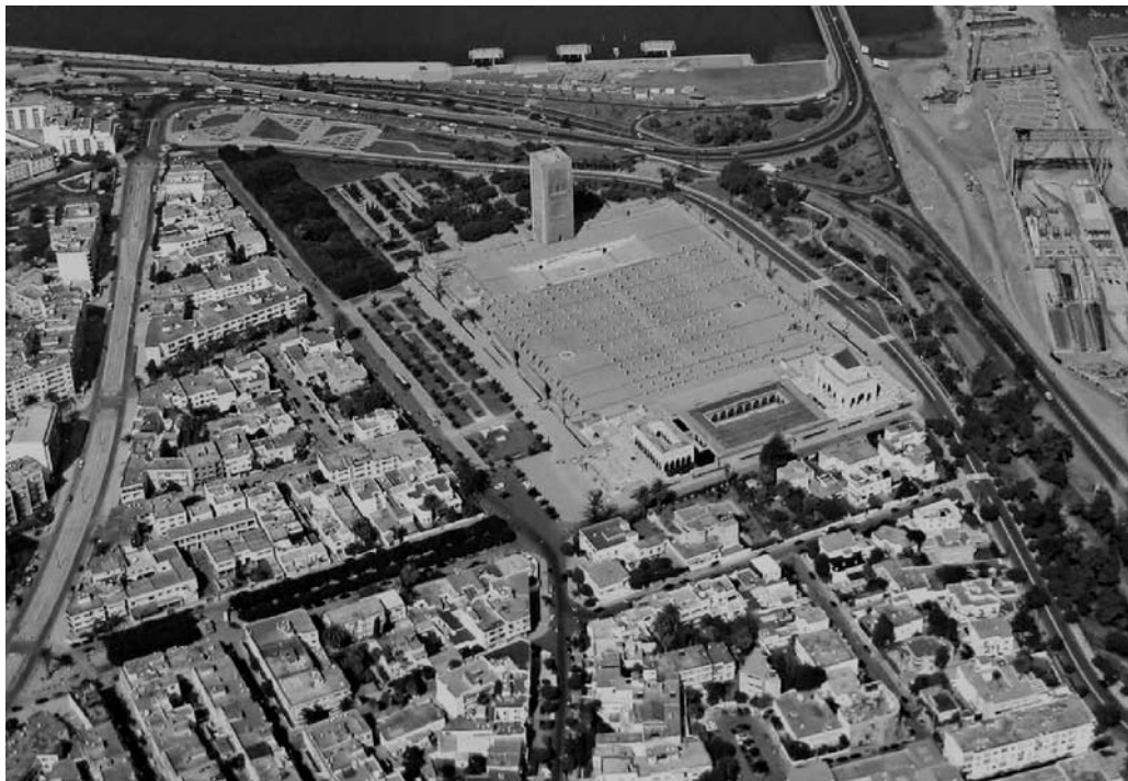
La mosquée de Hassan et son environnement immédiat
