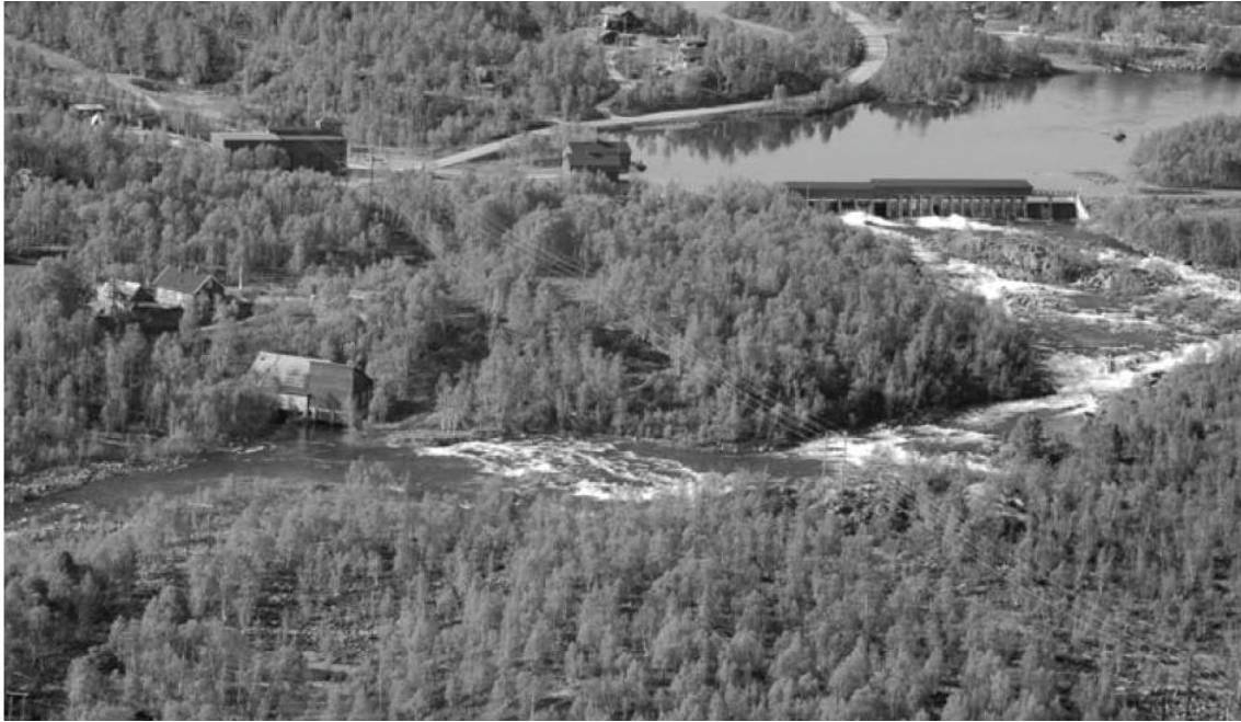
Centrale électrique de Kuråfossen
