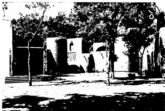
MUSÉE NATIONAL, Bamako. Locaux actuels (architecte : Jean-Loup Pivin, en collaboration avec Pascal Martin-Saint-Léon, Moustapha Soumaré, Mamadou Dembelé). La conception de l'espace muséal tient compte d'un coût minimal de construction, de fonctionnement et d'entretien et utilise des technologies « douces » : technique de construction en banco stabilisé, utilisation systématique de l'éclairage naturel, principe général de ventilation naturelle (voir « Bamako, Mali. Naissance d'un musée », Museum , vol. XXXIII, n° 1, 1981). [Photo : Georges Meurillon.]
