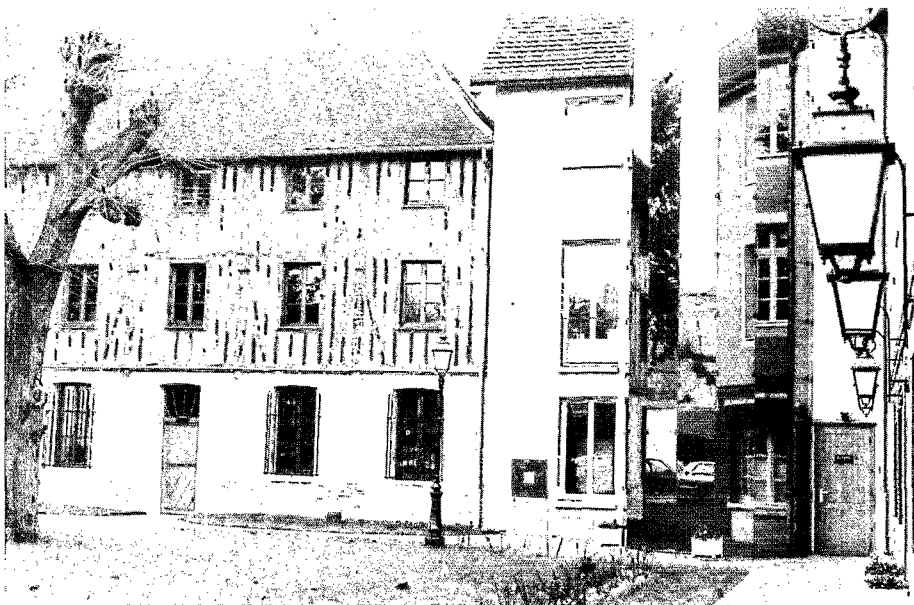
Les bâtiments de l'ensemble musée-centre de documentation récemment rénovés grâce en partie au concours d'élèves de l'enseignement technique.
