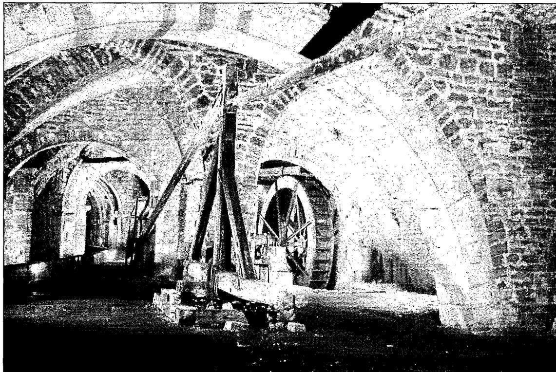
*La roue hydraulique du système de pompage de la saumure dans les souterrains des salines de Salins.*
