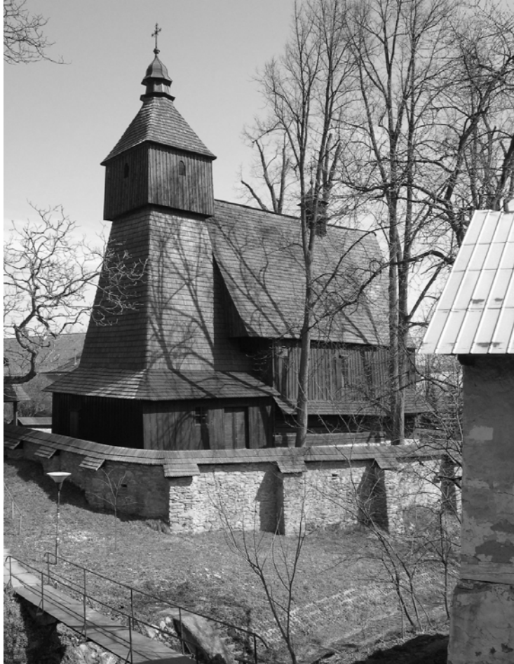
Église Saint-François à Hervartov, vue sud-est
