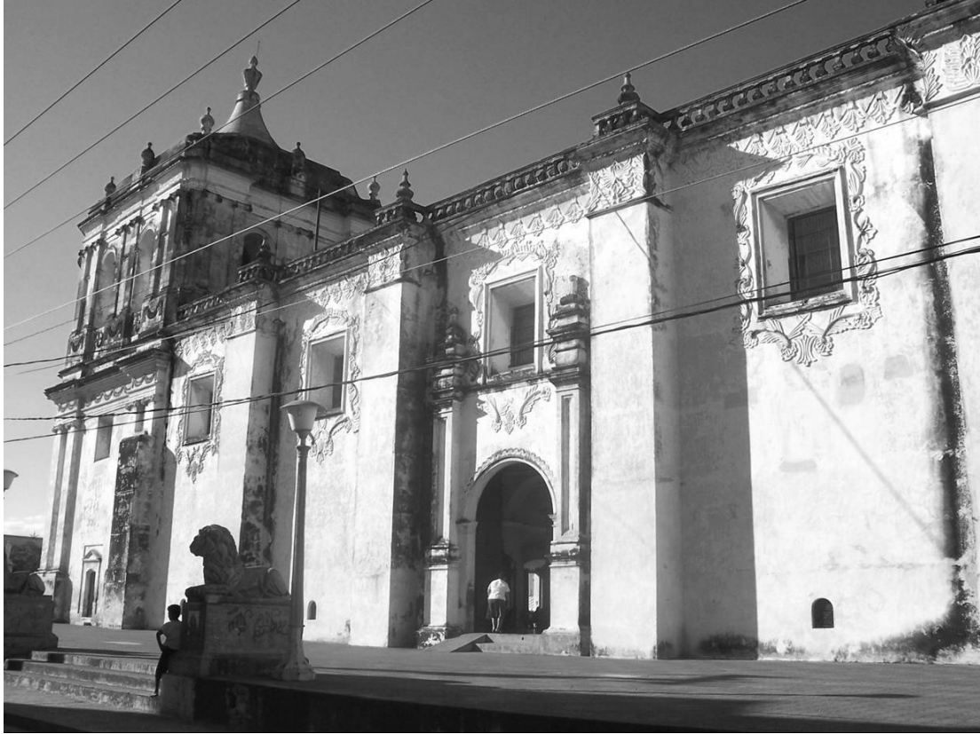
Façade sud vue de l'est
