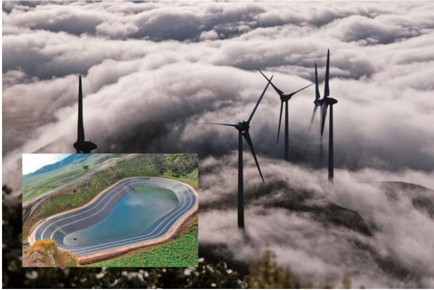
Imagen: Gorona del Viento. Depósito superior y parque eólico de la central hidroeléctrica.
