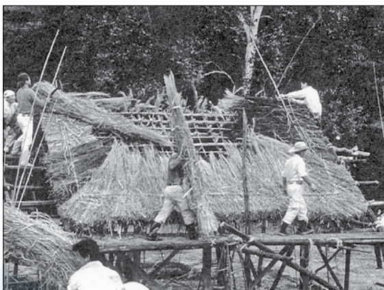
7 実物大模型による茅葺き訓練 Thatch training
