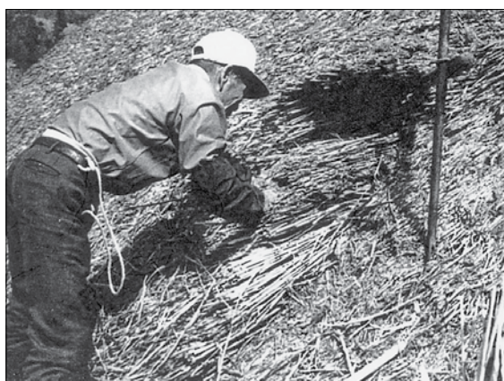
1 差木を入れて屋根面を持ち上げ、古茅を引き出す
