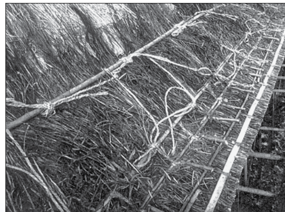
2 軒付け工程(古茅・パイ・カヤワリ) Thatching of eaves
