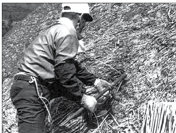
3 差木を外して屋根面を馴染らす
