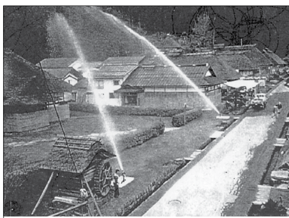
5 放水訓練 (福島 大内宿) Hosing drill
