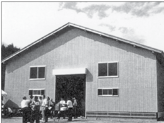
5 国庫補助事業による茅保存庫の建設 Storage warehouse
