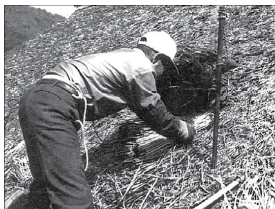
2 屋根の隙間に短い新茅を差し込む
