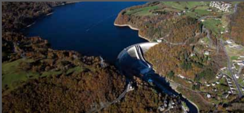
Bort-les-Orgues dam - © EDF
