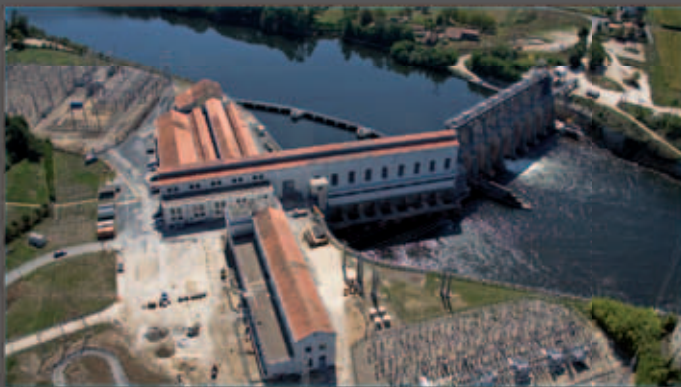
Barrage de Tuilières - © EDF
