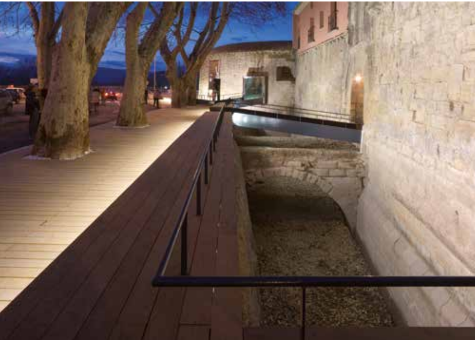
Intervención en la muralla de Logroño (detalle). Arquitectos Eduardo Pesquera y Jesús Ulargui, 2006-2009, Logroño, La Rioja, España. Foto de Eduardo Sánchez.
