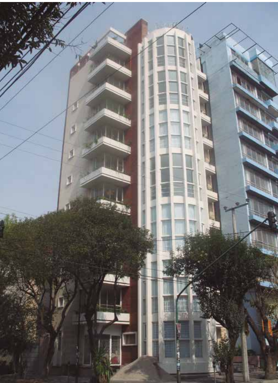
Edificio de Río Balsas, Arquitecto Mario Pani, 1943-44, México D.F. Restaurado por el Arquitecto Juan Carral. Foto Louise Noelle.
