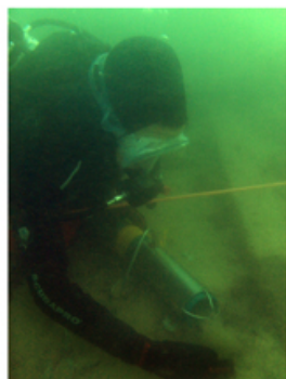
Limpeza superficial através de sugadora hidráulica
