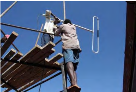
Fixation de l'aérien sur le mât d'antenne construit sur place
