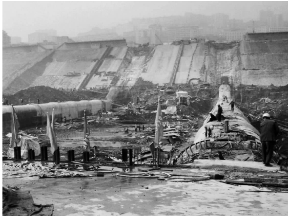
图 39 斜坡交通廊道施工情况 (3)
