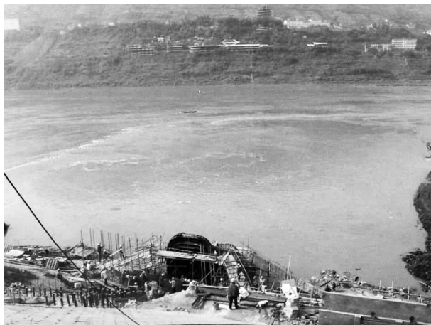
图 37 斜坡交通廊道施工情况 (1)
