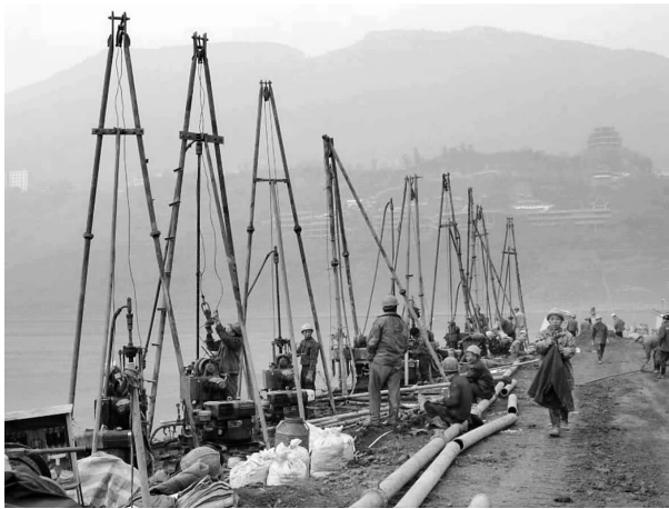
图30 围堰施工时的情况
