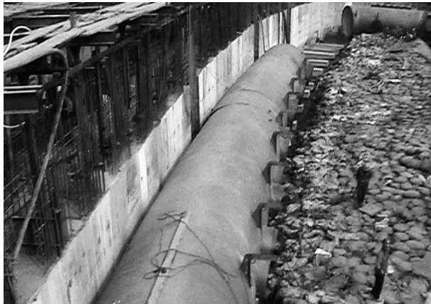
图 45 参观廊道安装在保护壳腔体内 (I)
