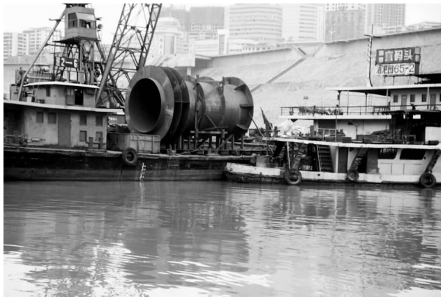
图 28 预埋管接头运输情况
