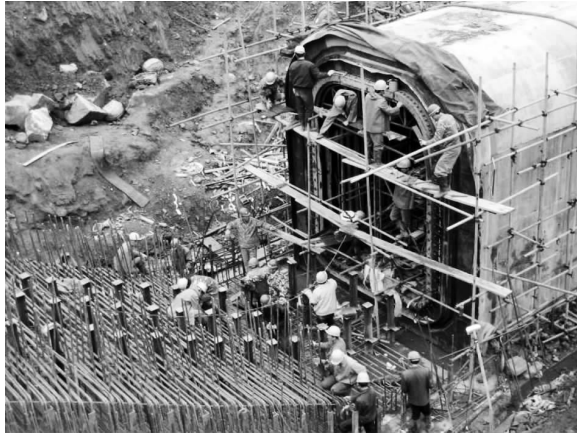
图 38 斜坡交通廊道施工情况 (2)
