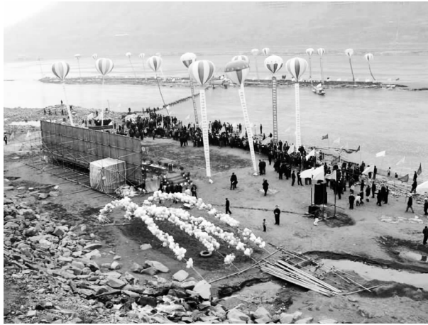
图22 白鹤梁水下保护工程开工
