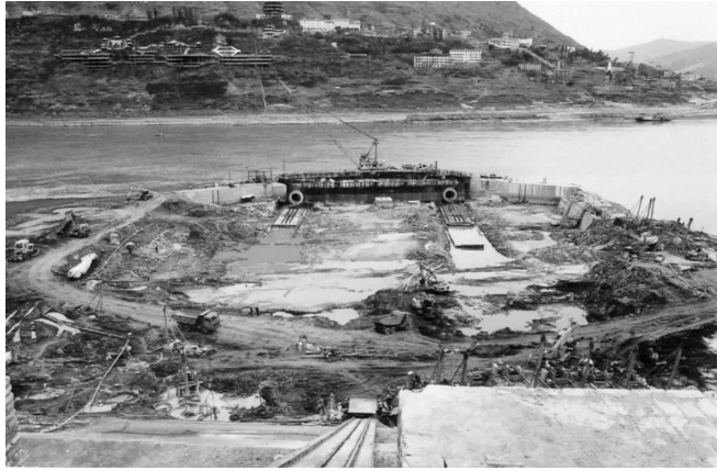
图 32 合拢后的施工现场
