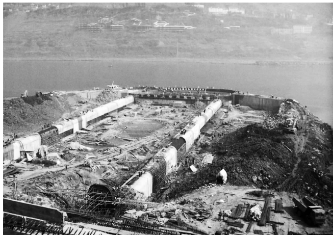
图 34 上下游水平交通廊道的施工情况 (2)
