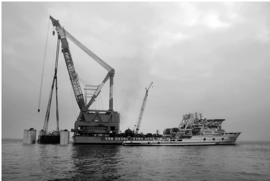
图4 沉箱整体打捞出水
