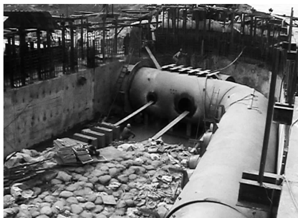
图47 参观廊道安装在保护壳腔体内（III）
