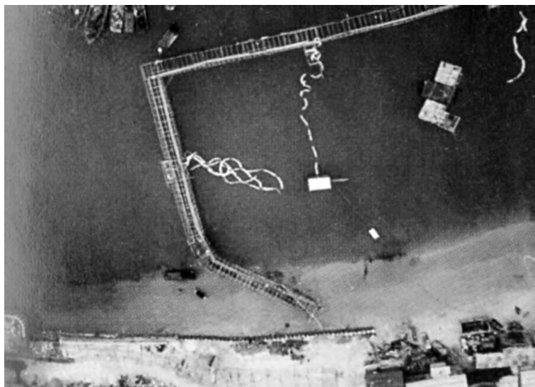
图3 钢沉井定位下沉
