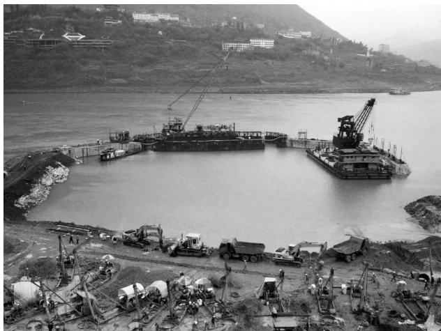
图31 围堰快接近完成时的情况
