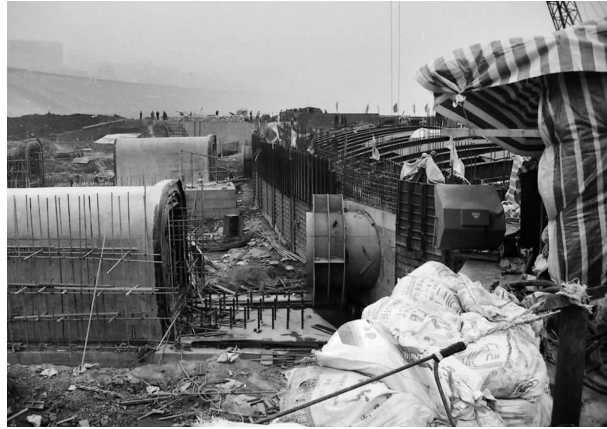
图 36 上下游水平交通廊道的施工情况 (4)
