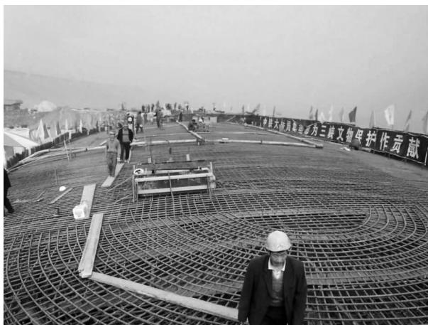
图 49 浇筑钢筋砼穹顶的钢筋网
