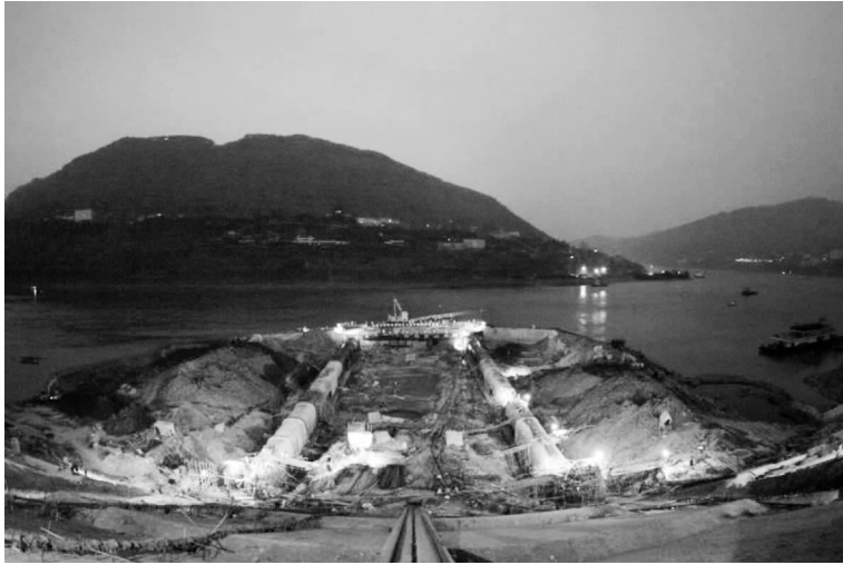
图 41 水平和斜坡交通廊道接近完成时的夜景
