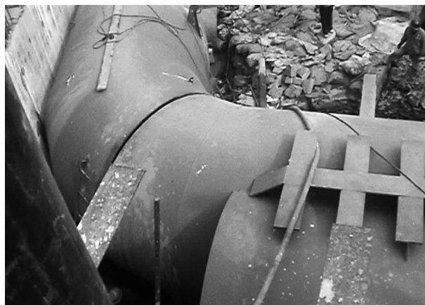
图46 参观廊道安装在保护壳腔体内（II）
