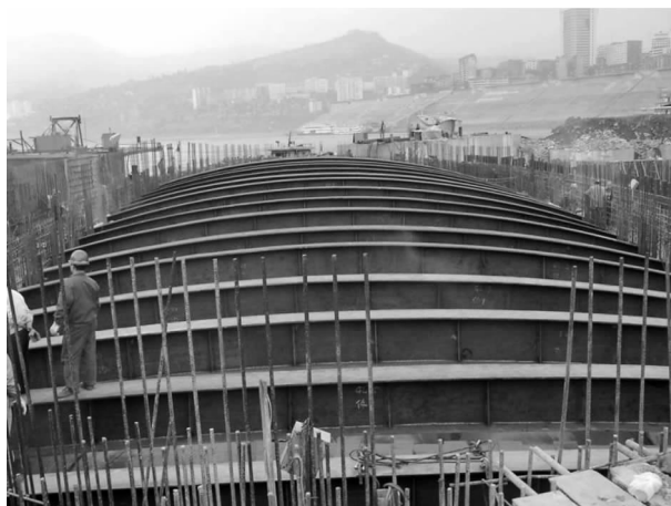
图48 穹顶钢骨架
