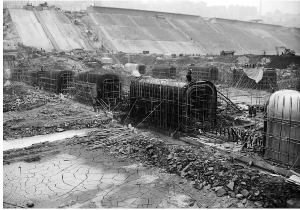
图 35 上下游水平交通廊道的施工情况 (3)
