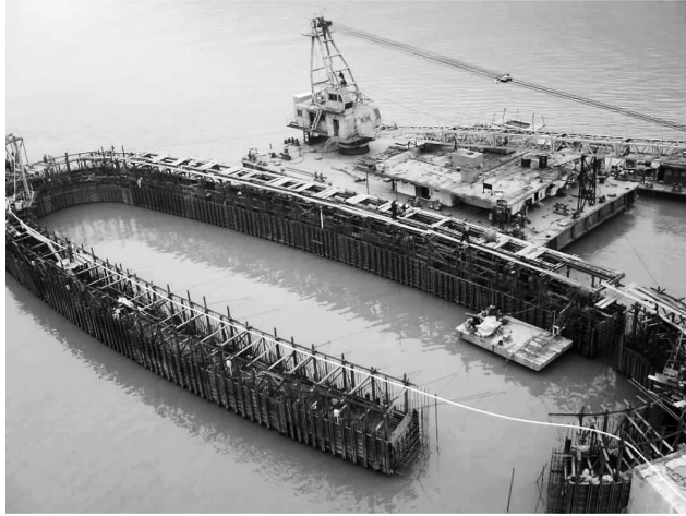
图 27 保护体导墙施工的情况
