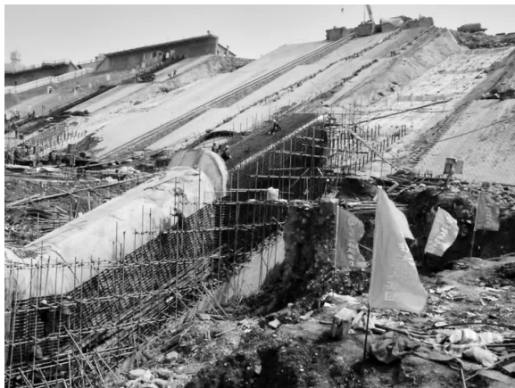
图 40 斜坡交通廊道施工情况 (4)
