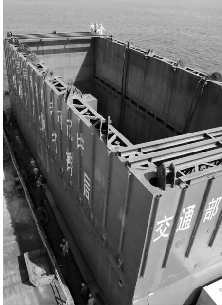
Fig1: Steel caisson
