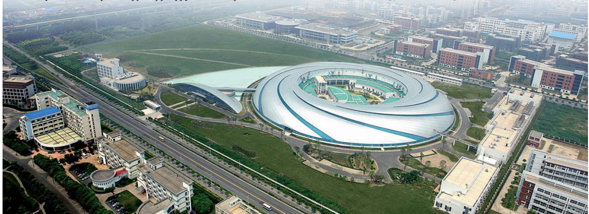
Шанхайский генератор синхротронного излучения, работа над созданием которого завершилась в апреле 2009 года
