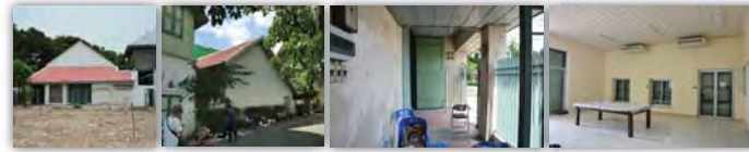
สภาพปัจจุบัน (อาคารหมายเลข 3)
