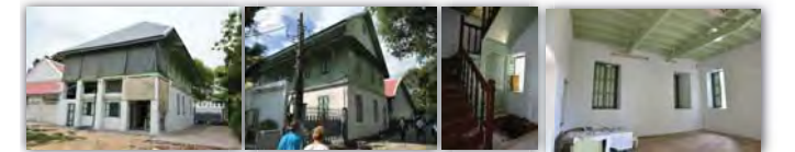
สภาพปัจจุบัน (อาคารหมายเลข 4)
