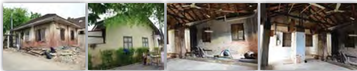
สภาพปัจจุบัน (อาคารหมายเลข 5)
