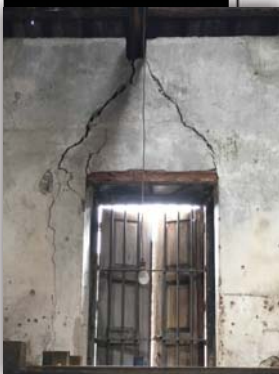
กำลังอัดไม่เหมาะสมกับการรับน้ำหนักแบบกดเป็นจุด
