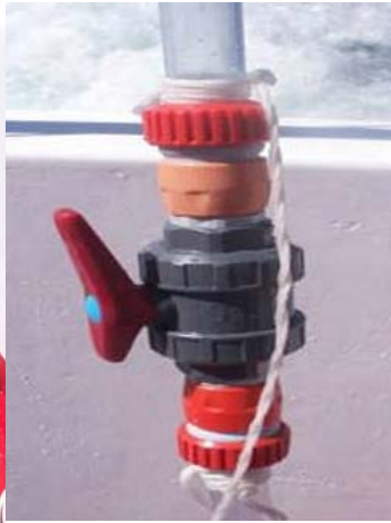
Llave de paso preparada para su descenso en el agua, en posición de abierto.
