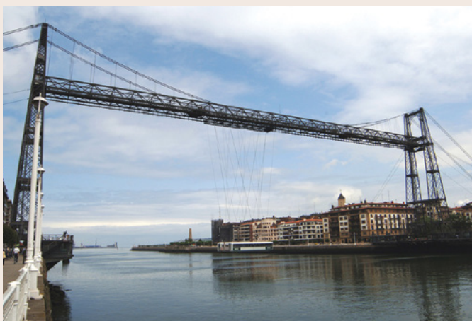
Ponte Vizcaya (Espanha)
