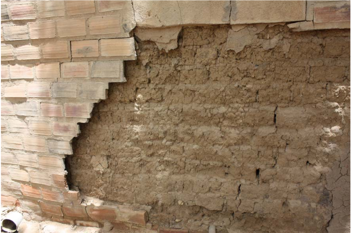
Nouveau matériau de construction et ses conséquences dans le temps
