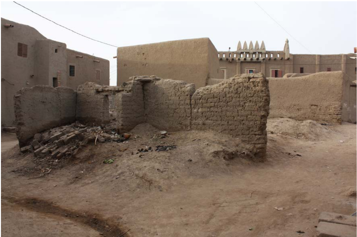
Un bâtiment abandonné et la modification de la morphologie du tissu ancien
