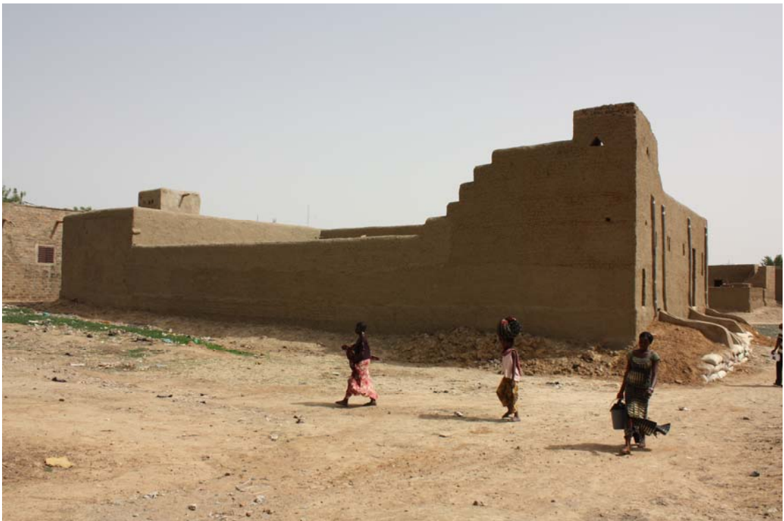
Nouvelle construction dans la mare, une zone d'inondation
