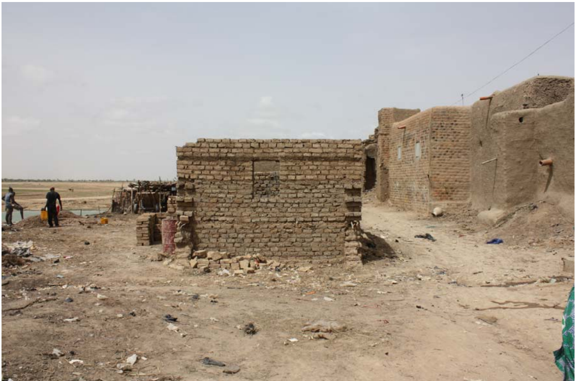
Des nouvelles constructions avancent de plus en plus vers les berges
