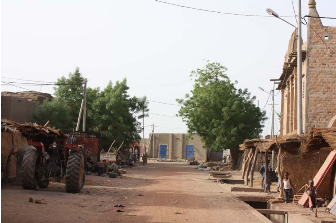
Nouvelle construction dans un espace public qui dépossède l'espace urbain d'une vue « vista » directe vers la berge et empêche la circulation de l'air dans la ville.
