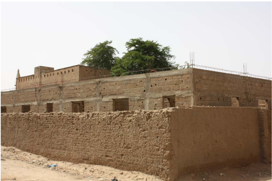
Nouvelle construction sans une considération de typologie traditionnelle de Djenné
