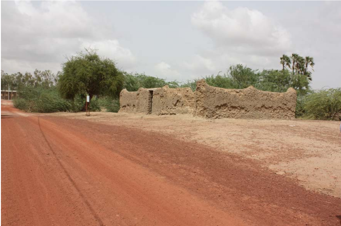
Une route à travers un site classé : le besoin d'harmoniser les politiques du développement de la ville et de la sauvegarde de patrimoine
