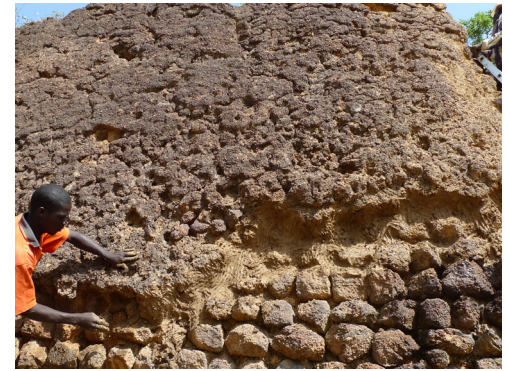
Conservation des enduits en terre recouvrant les murs en blocs de latérite © David Gandreau, CRAterre
