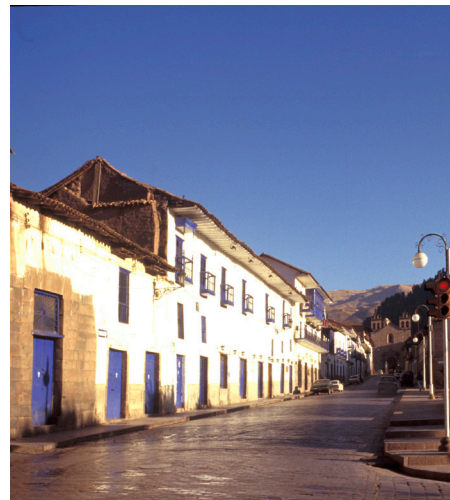
Rue du centre historique en adobe de Cuzco
