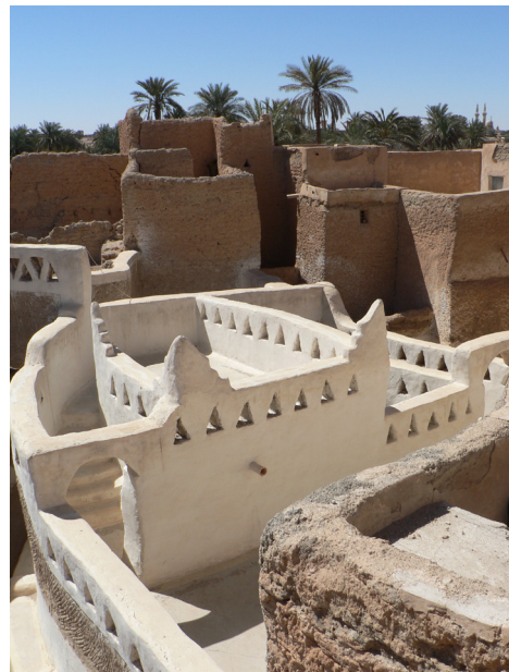
Toitures avec acrotères enduites de plâtre
