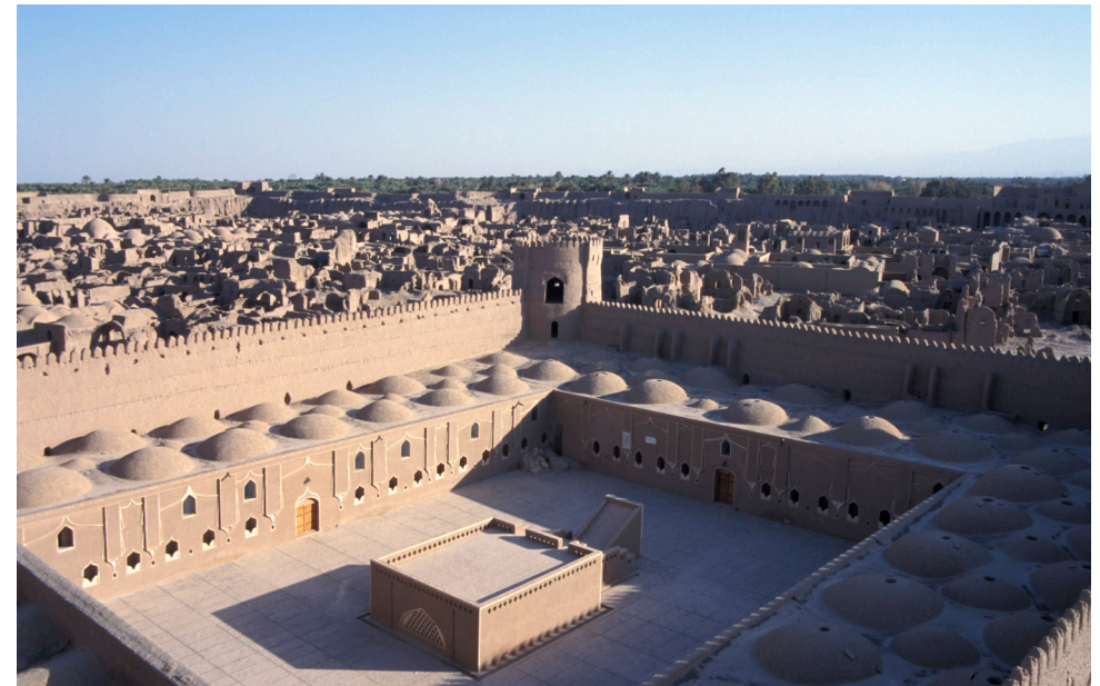
Écuries, citadelle de Bam avant sa destruction par un séisme en décembre 2003 © Hubert Guillaud, CRAterre
