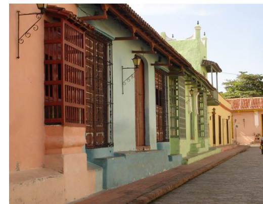
Façades du XVIII - XIX siècle, torchis. © OHC Camagüey
