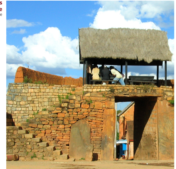
Porte fortifiée en terre et pierres ouvrant l'accès à la colline sacrée © Sébastien Moriset, CRAterre
