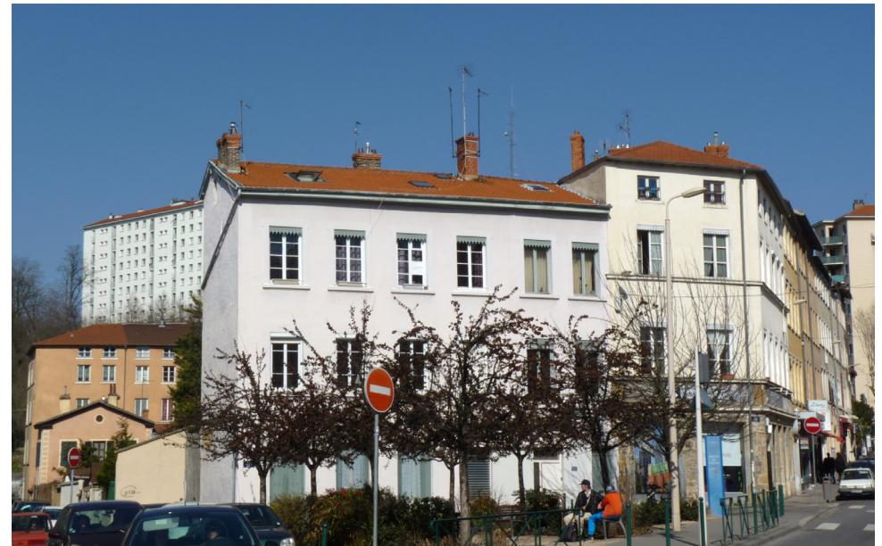
Lyon : Quartier Saint Just, Immeuble en pisé à la jonction de la rue Benoist Mary et de la rue des 4 colonnes © Sébastien Moriset, CRAterre
