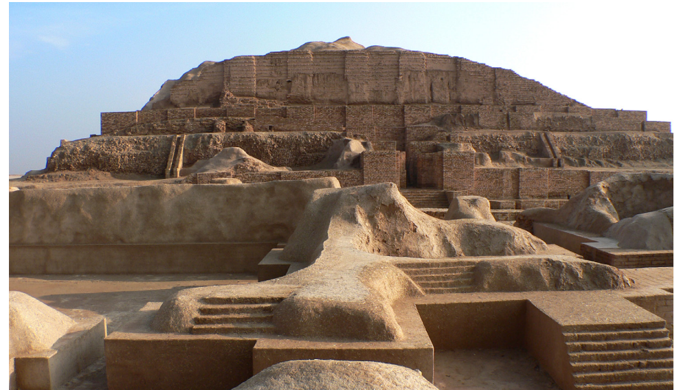
Façade nord de la ziggourat avec les vestiges en adobes au premier plan © Sébastien Moriset, CRAterre
