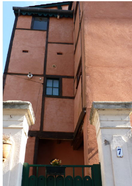
Lyon : Quartier Saint Just, constructions en colombage, rue Saint Fiacre © Sébastien Moriset, CRAterre
