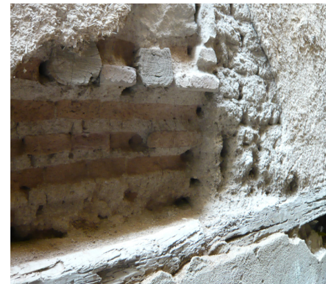
Cœur historique de la ville de Damas, détail d'un enduit de terre abîmé laissant apparaître les briques de terre © Jean-Marie LeTiec, CRAterre
