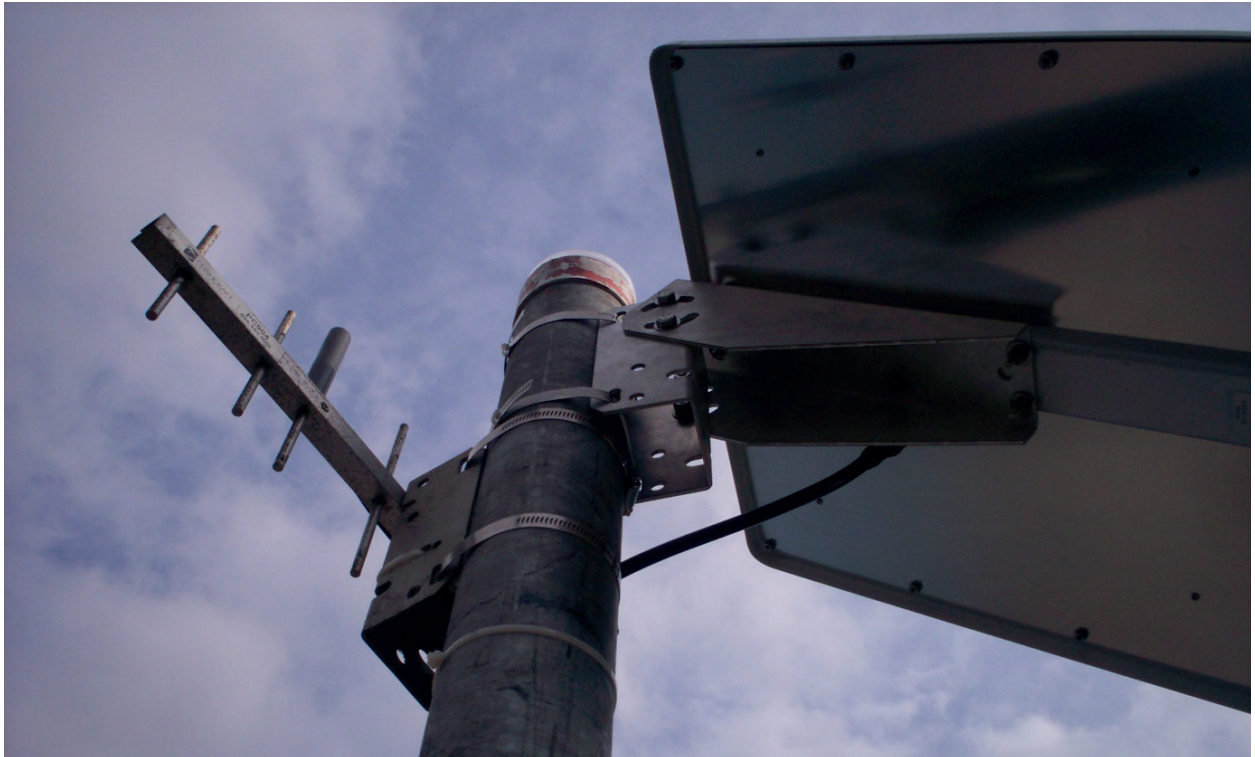
Figure 7.6 Une antenne de transmission radio locale compacte à Antofagasta au Chili. (Photo SHOA).
