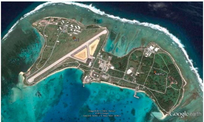
Sur Roi, deux bassins collecteurs bétonnés (visibles sur la gauche de l'image) sont utilisés pour recueillir l'eau de pluie et recharger artificiellement les eaux souterraines lorsqu'il existe une capacité excédentaire. Sources : Google Earth
