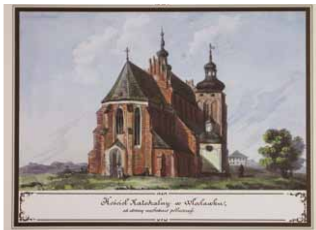
Exemple d'enquête d'inventaire coordonnée par Kazimierz Stronczyński (1844-1855). Illustration de la cathédrale à Włocławek.
