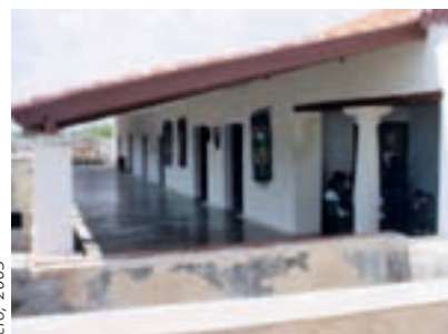
Portal de la casa del Gobernador después de la intervención.
