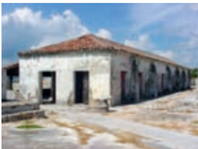
Primera etapa de trabajo en la casa del Gobernador.
