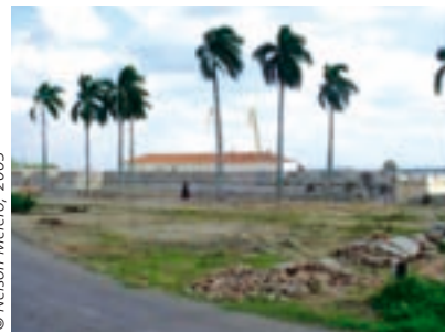
Vista general de la fortificación desde el acceso vehicular.
