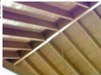
Techo de madera con pendientes después de la intervención.
