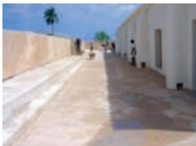
Explanada y muros en la parte posterior de la casa del Gobernador durante los trabajos.
