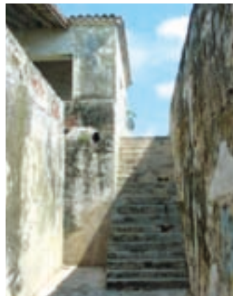
Modificación del desarrollo de la escalera y muro construido en la rampa de acceso a la planta alta.
