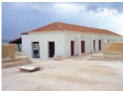
Vista general de la casa del Gobernador y las áreas exteriores después de la intervención.
