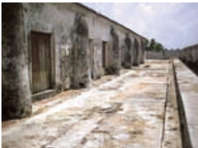
Primera etapa de trabajo en las explanadas inmediatas a la misma.
