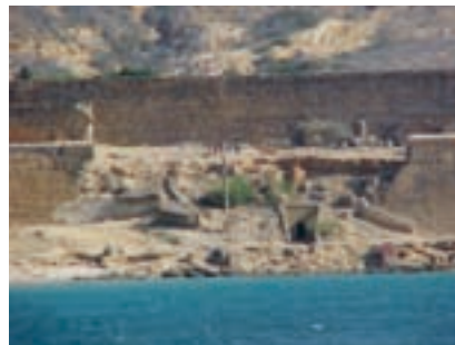
Cortina norte demolida.
