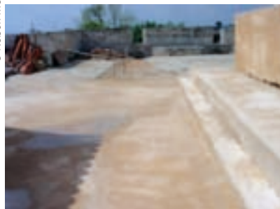
Vista general de los trabajos en las explanadas una vez concluidos.
