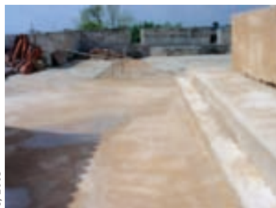
Trabajos en las bancadas y los parapetos.
