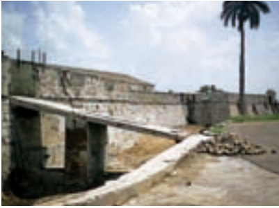
Puerta y puente de hormigón armado construidos en la cortina sur en 1930.
