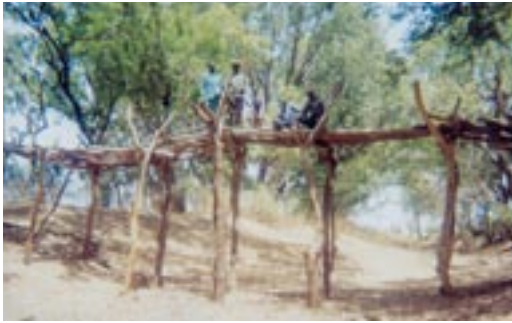
Pont de bois construit pour donner accès à des zones protégées pendant la saison des crues
