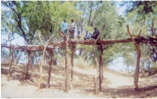
Деревянный мост построен для прохода в заповедник в период дождей
