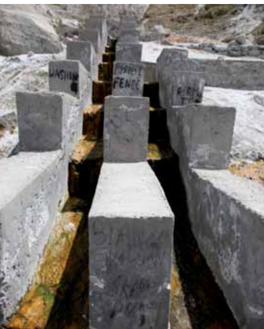
62. Canalisation de la source chaude pour le bain et le linge, Panamik, Karakorum, Inde © UNESCO / Olivier Brestin
