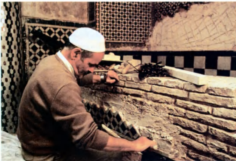
Ci-contre, travaux de restauration. Le plâtre sculpté joue un rôle décoratif majeur dans l'architecture traditionnelle.
