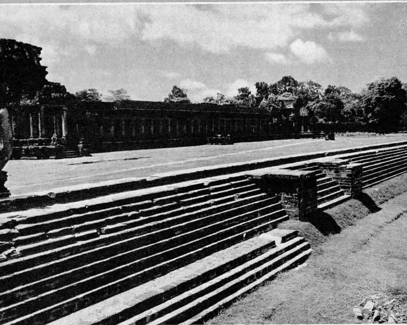
Ci-dessus, gradins d'Angkor Vat, après leur récente reconstruction. L'eau de la douve avait provoqué leur éboulement (ci-dessous). Les éléments originaux ont retrouvé leur belle ordonnance ; des fondations de béton armé et des drains les protègent désormais.
