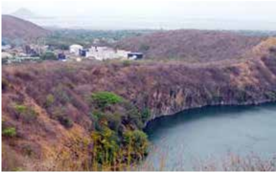
Figura 2.4 Refinería en la orilla norte de la Laguna de Asososca
