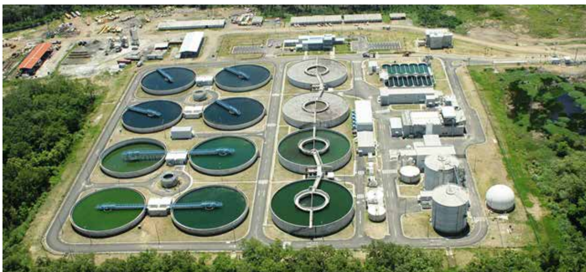
Figura 5. Planta de tratamiento de aguas residuales del proyecto de saneamiento de la Bahía de Panamá
