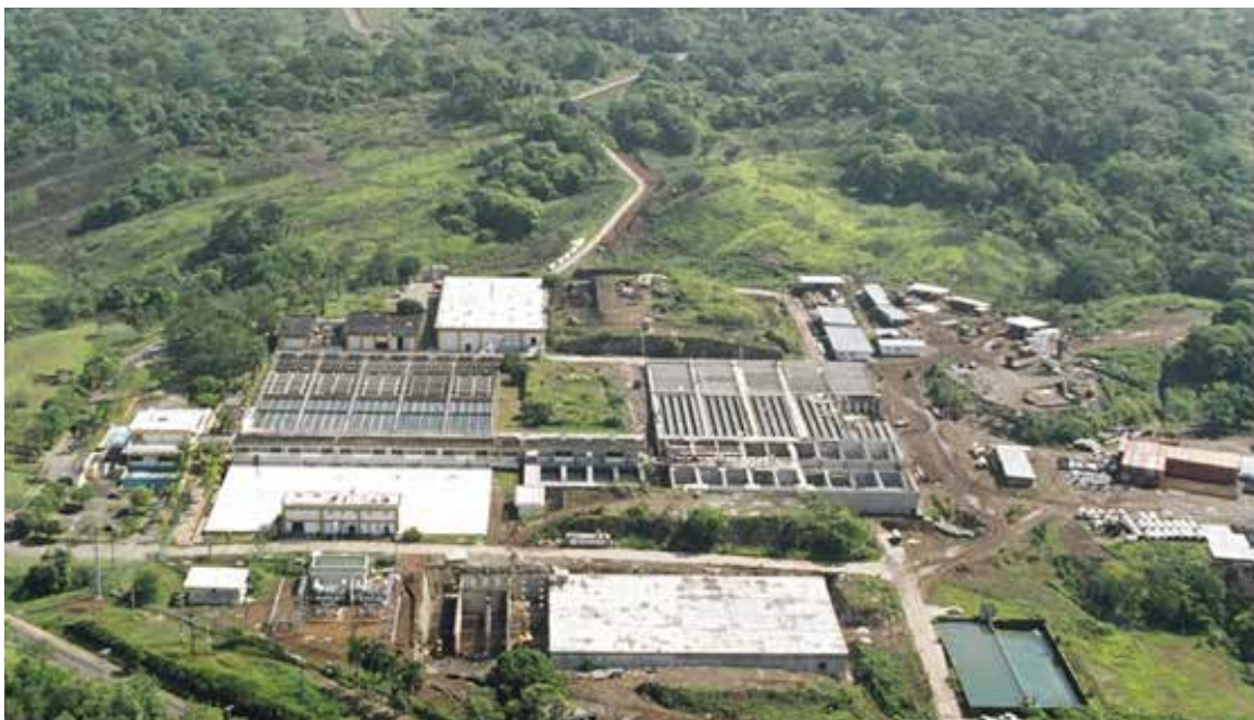
Figura 4. Planta de tratamiento de aguas residuales del proyecto de saneamiento de la Bahía de Panamá
