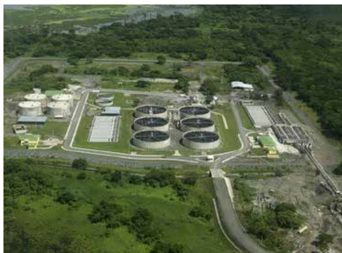
Figura 4.1 Moderna planta de tratamiento de las aguas residuales de la ciudad de Managua
