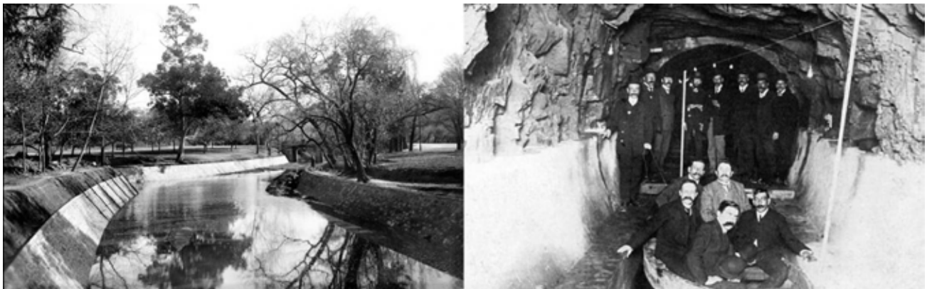
Figura 2. Arroyo Miguelete en Montevideo. Visita a la Red Artega hacia 1900.
