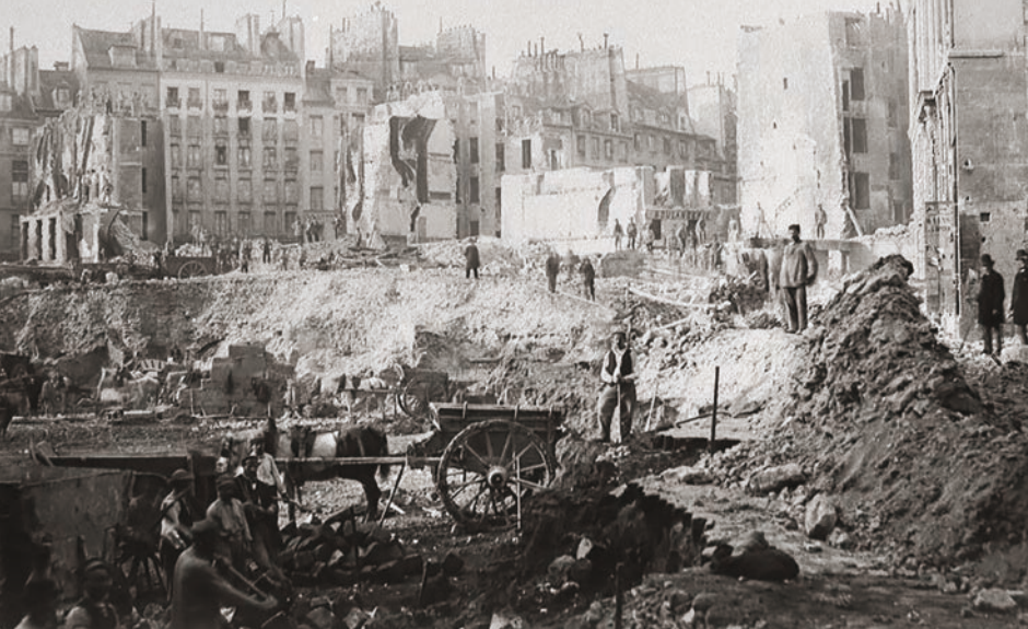
Travaux majeurs de transformation urbaine dirigés par le baron Haussmann sur l'avenue de l'Opéra, Paris (France) © Charles Marville, 1862. Source: gallica.bnf.fr - École nationale des ponts et chaussées*
