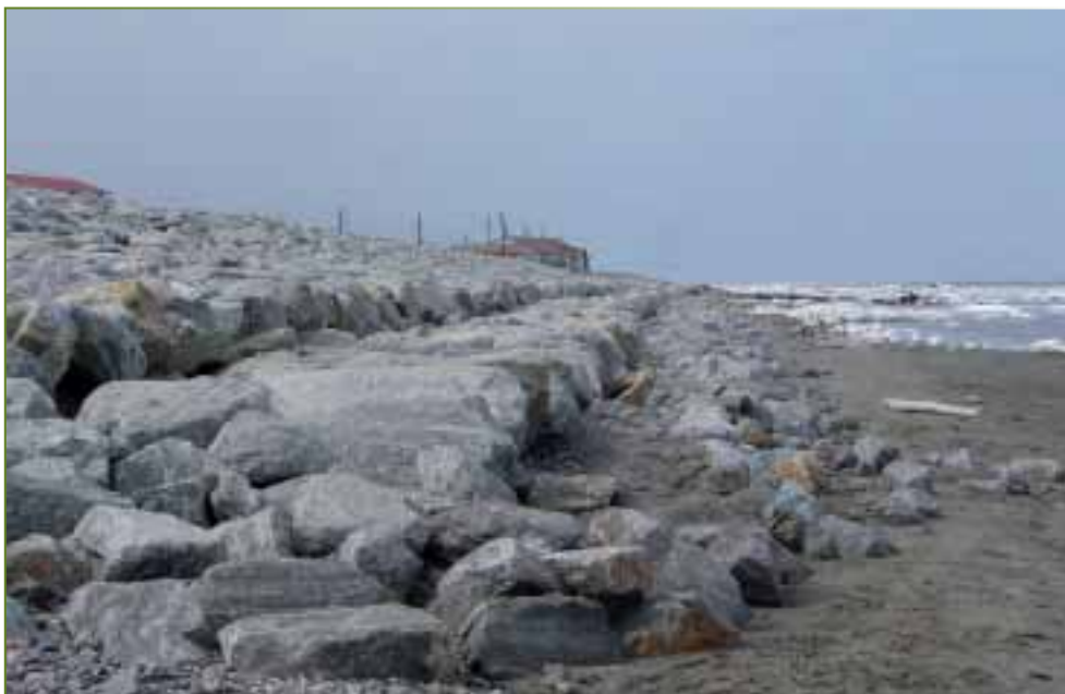
Revêtement de Shishmaref (photo: Sharon McClintock).
