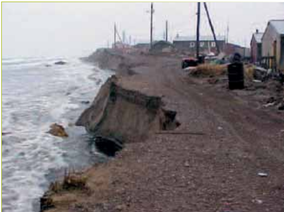
Sur la côte occidentale de l'Alaska, des maisons de village, des caves de réfrigération, les systèmes et infrastructures d'adduction d'eau sont sapés par la mer, ce qui porte atteinte à la santé des résidents (photo : Nome Nugget Newspaper).
