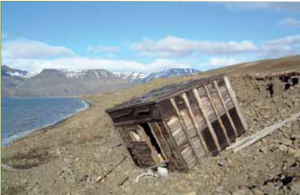
Une petite cabane dans le Svalbard glisse sur la pente d'une côte érodée (photo : Urban Wråkberg).
