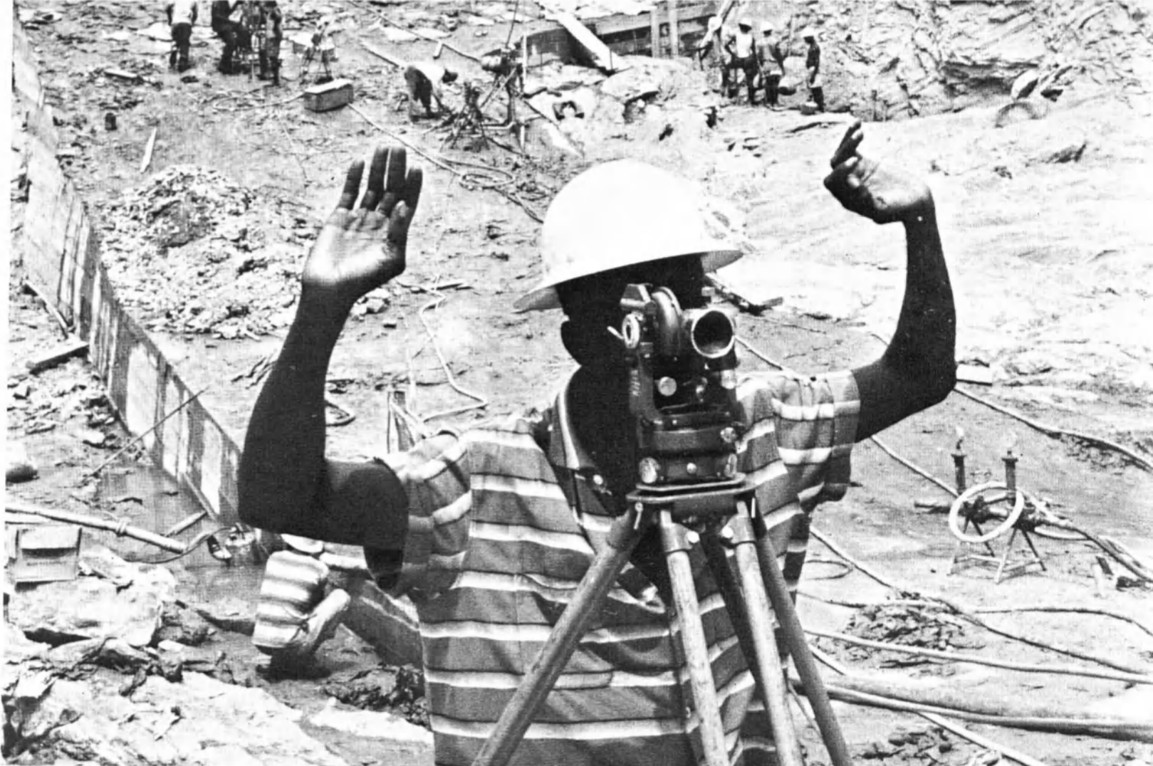
Sur un chantier du Ghana, près du fleuve Volta, un contremaître, l'œil au théodolite, rectifie un tracé. Un important complexe industriel se développe dans la région d'Accra grâce à la proximité du nouveau port de Tema et à l'achèvement du grand barrage d'Akosombo sur le fleuve Volta, dont les deux premières turbines, mises en activité en août 1965, constituent déjà une importante source d'énergie électrique.
