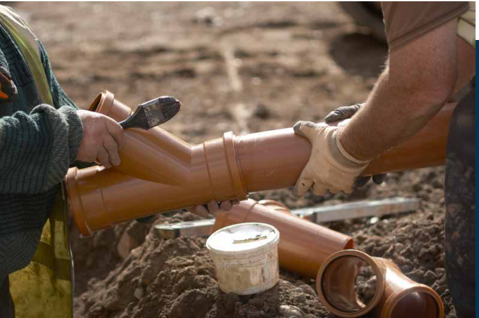
Ouvrier installant les canalisations d'égouts sur un chantier Photo : © iStock.com/ezza116
