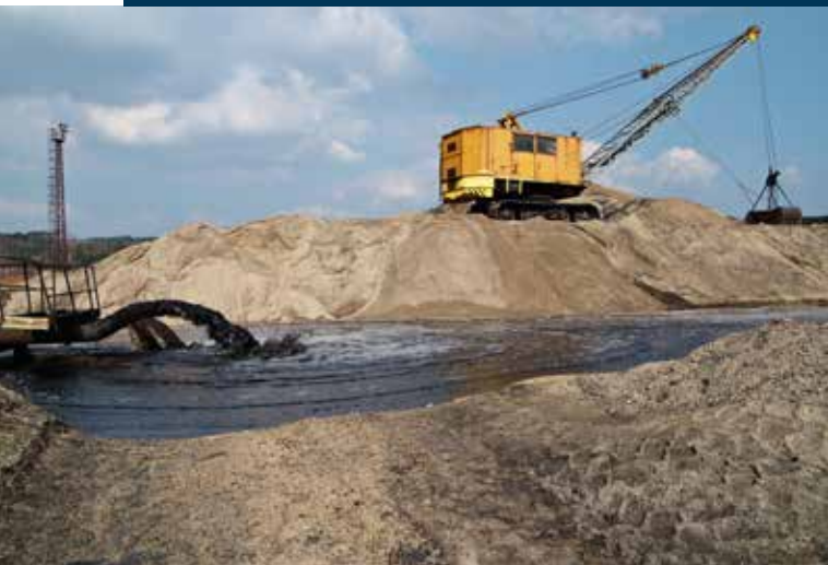
Écoulement de déchets miniers
