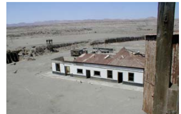
Oficina de Santa Laura, desde la planta de Lixiviación | Santa Laura's Office, from the Leaching plant Eugenio Correa, 2003
