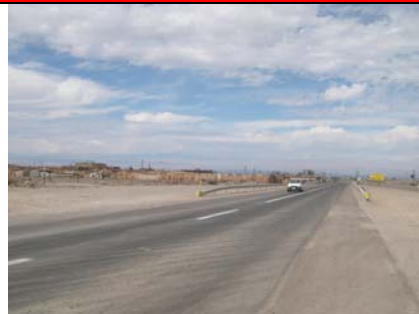
Vista de la bodega y talleres desde la Ruta A-16
