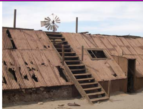
Escalera de acceso a los molinos primarios
