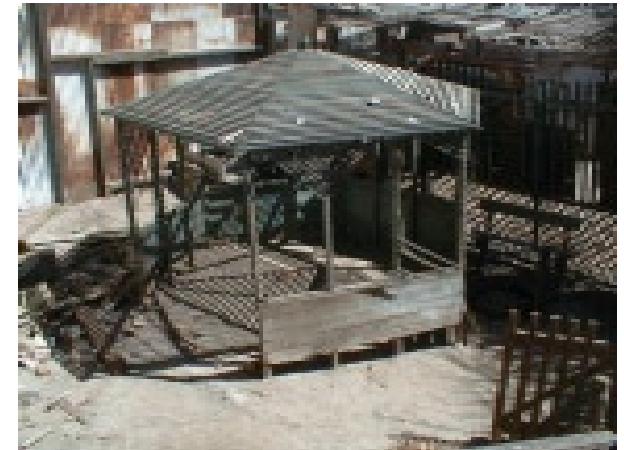
Pérgola, patio interior de una de las Viviendas en hilera Pergola, interior yard of one of the terraced houses Genaro Cuadros, 2001
