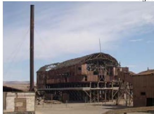
Se puede apreciar la nueva losa de HA en segundo nivel (proyecto de consolidación estructural).
