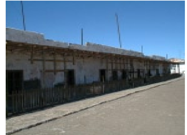
Casa en Hileras. Calle Tarapacá | Terraced houses. Tarapacá street Genaro Cuadros, 2001
