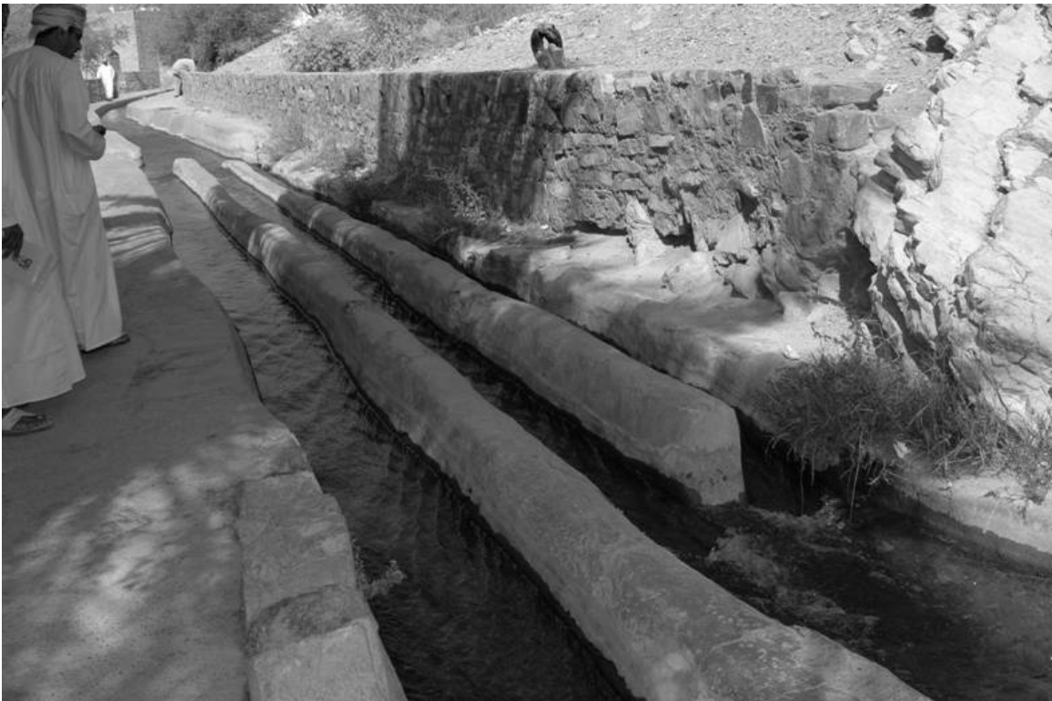
Point de distribution
