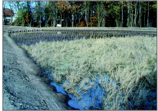
Fig. 10.1 Constructed wetland for storm water Karls-Einbau Project Company (photo: EKON Polska Biologia Inżynieryjna Sp. z o.o.)
