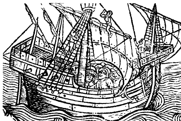
Илл. 25. Полностью оснащенная португальская каравелла при полном попутном ветре (конец XV в.); ее особенности: скругленный корпус, руль на ахтерштевне, квадратные паруса на бушприте и главной мачте, два свернутых треугольных паруса на двух бизань-мачтах и оружейные порты под планширами для артиллерийских орудий. Такие плавучие крепости, оснащенные для любых морей, использовали обе державы Пиренейского п-ова для завоевания Атлантического и Индийского океанов в конце XV в. (Гравюра из Estoria do muy noble Vespasiano Emperador de Roma , Torre de Tumbo, Лиссабон, 1496 г.)
