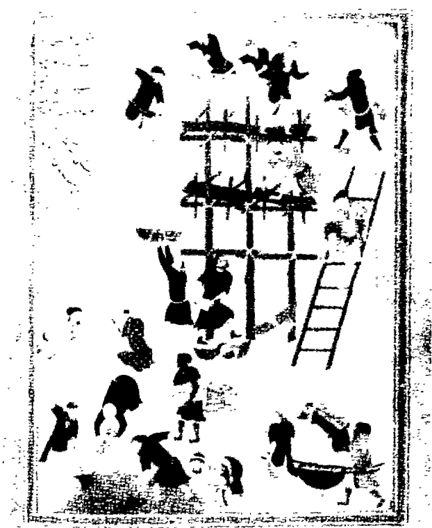
Илл. 27. Строительство замка Хаварнак, иллюстрация Бихзада из Герата для персидскоязычных сказок азербайджанского поэта XII в. Низами в рукописи, датированной 1494 г. Обращает на себя внимание изображение постройки из обожженного кирпича, заостренной арки, строительных лесов, применение тачки и известковой ямы. (С разрешения Британской библиотеки, Лондон, Великобритания)
