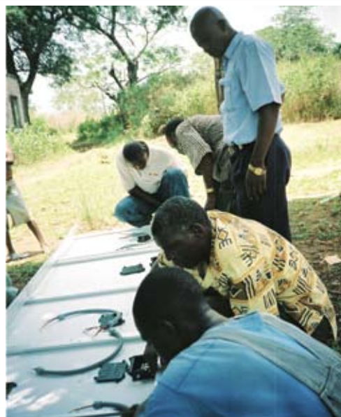
Au cours d'ateliers de formation sur le terrain organisés par l'UNESCO en 2003 à Bamako au Mali, câblage électrique de panneaux solaires et installation de systèmes photovoltaïques par les participants durant les travaux pratiques
