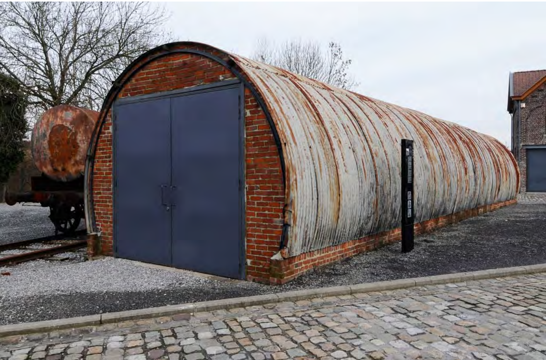
n°12 - Tunnel métallique semblable à ceux où étaient logés les travailleurs immigrés et leur famille à leur arrivée
