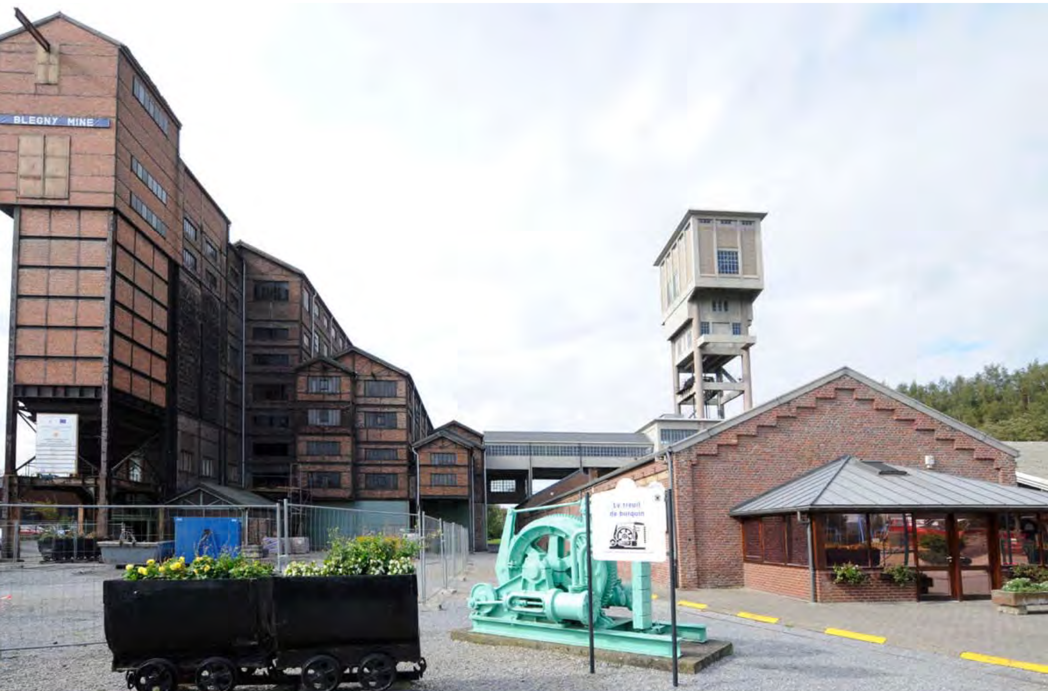
n° 2 - Vue générale sur le puits n°1 et le triage-lavoir
