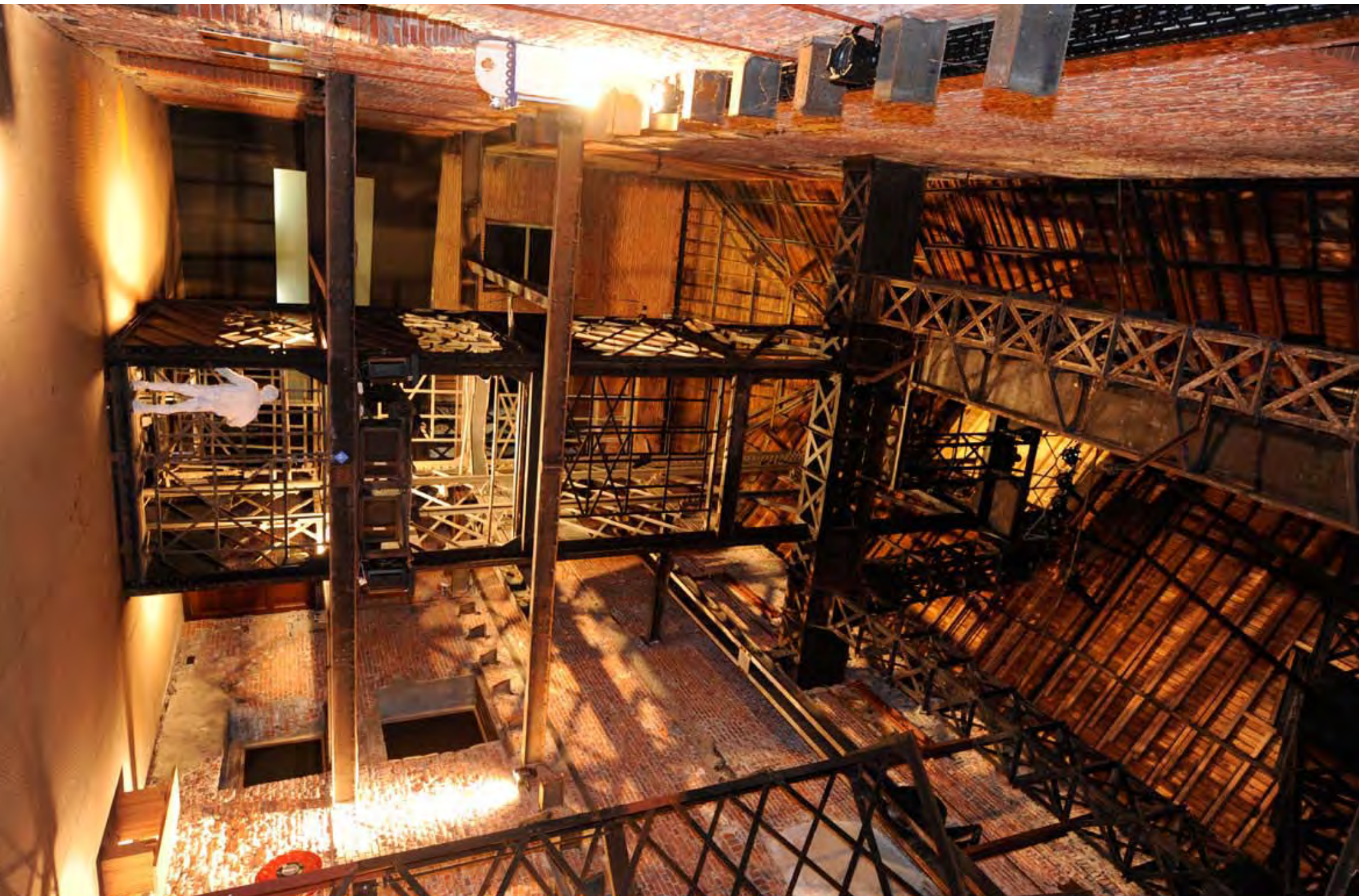
n° 10 - Les cages d'ascenseurs
