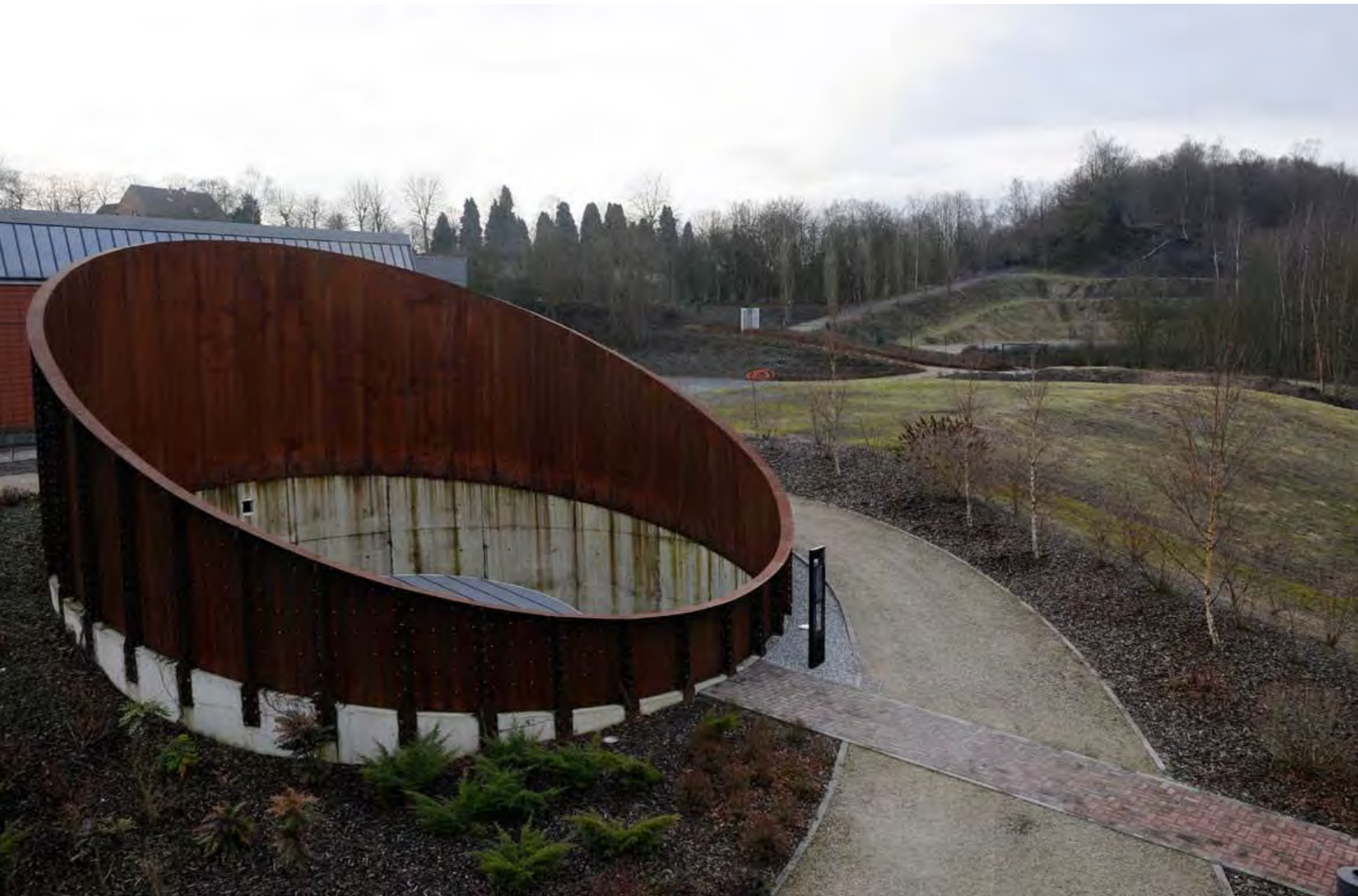
n°20 - Sécurisation de l'ancien puits Foraky
