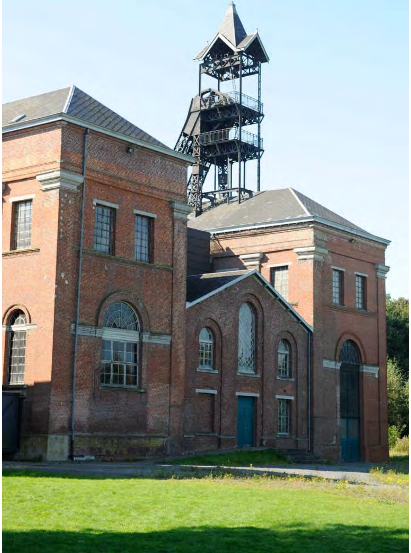
n° 9 - Les bâtiments du siège d'exploitation
