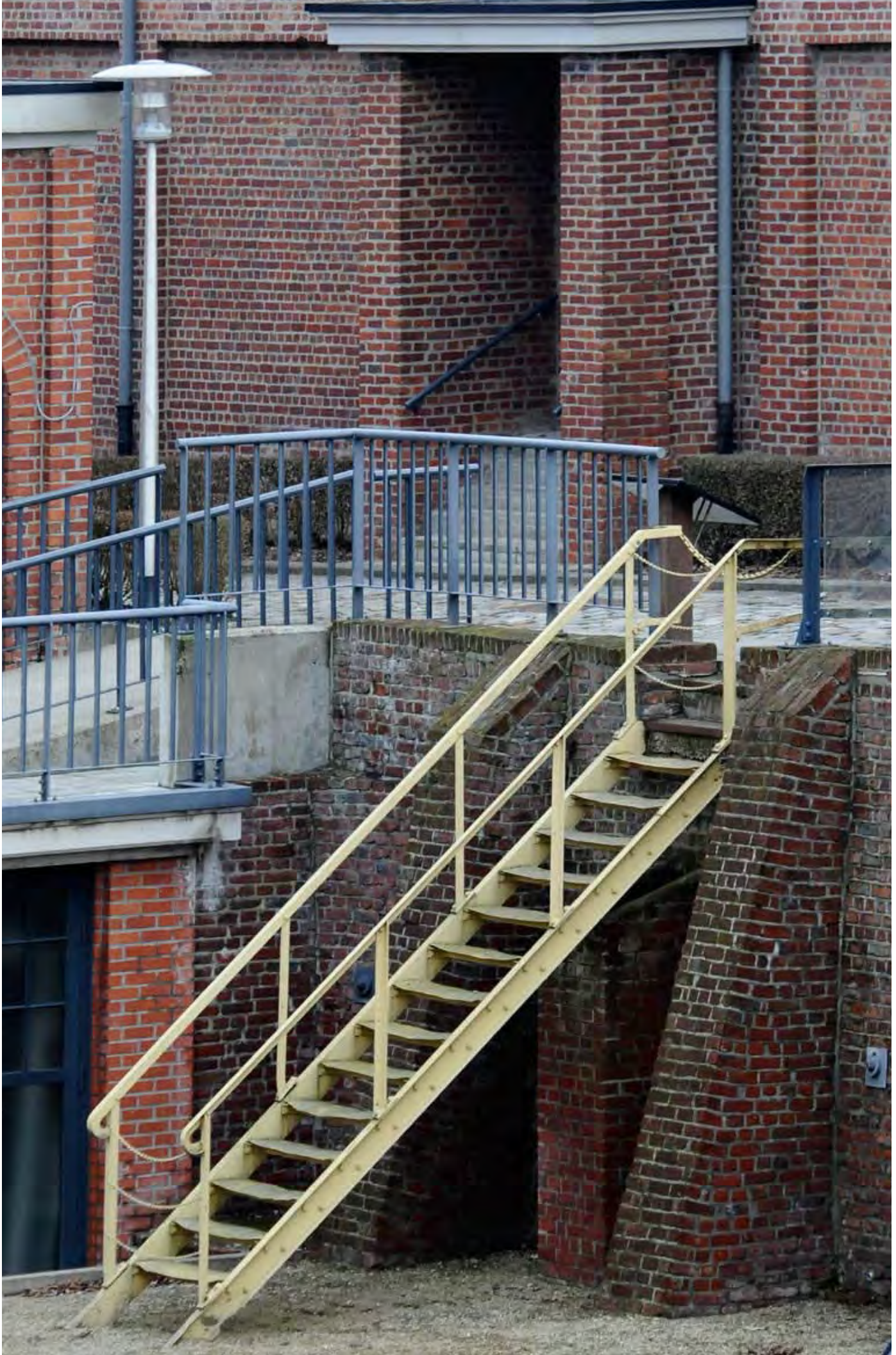
n°17 - L'escalier dit du «Roi»
