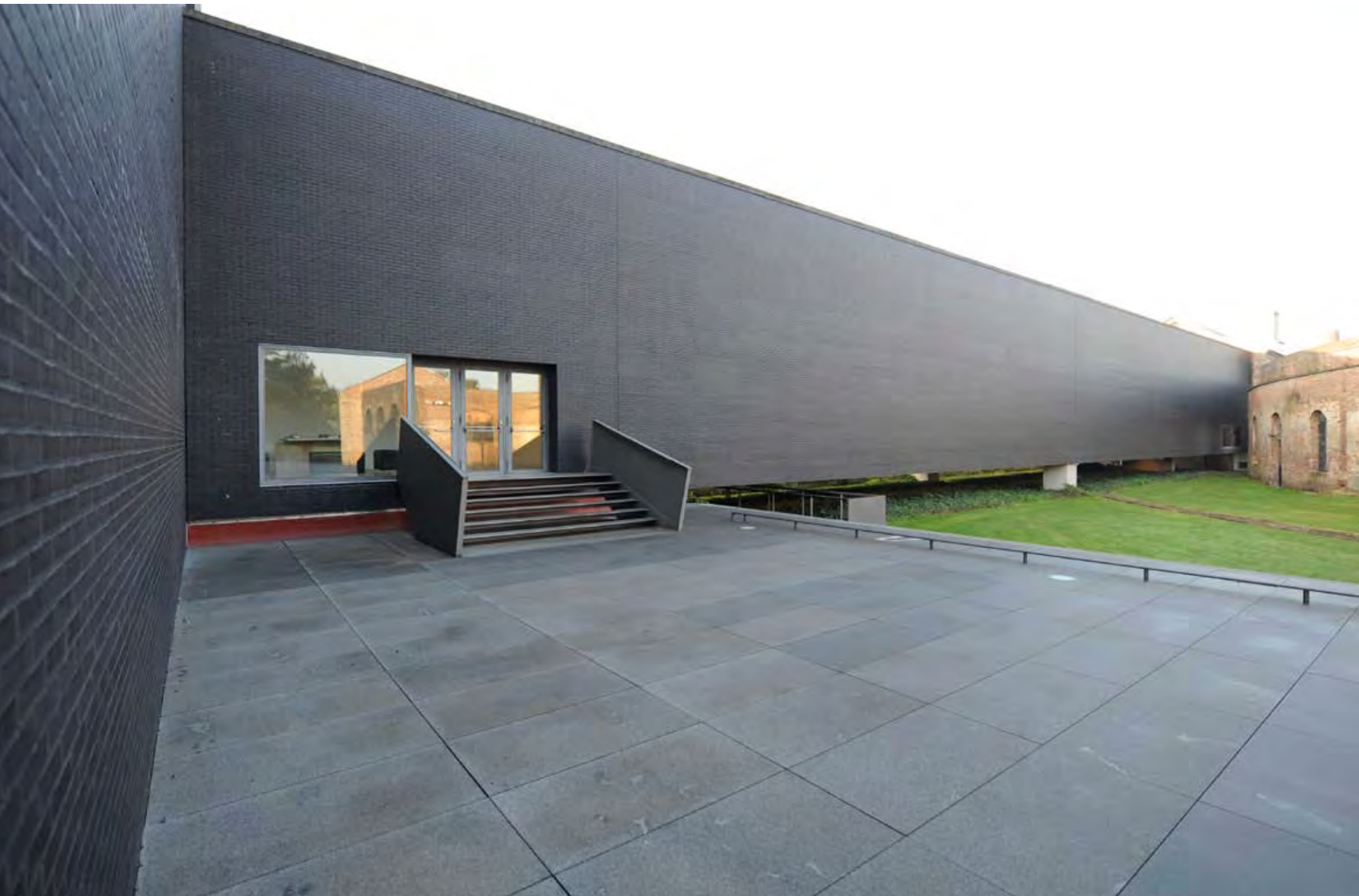
n° 13 - Le nouveau bâtiment du MAC'S
