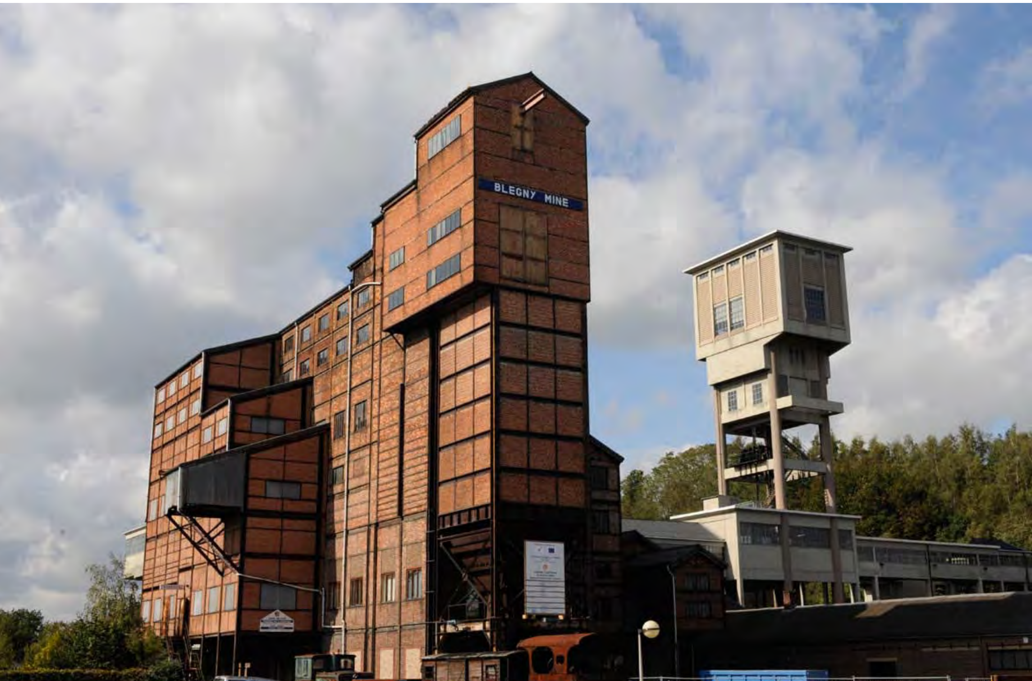
n° 3 - Vue générale sur le puits n°1 et le triage-lavoir
