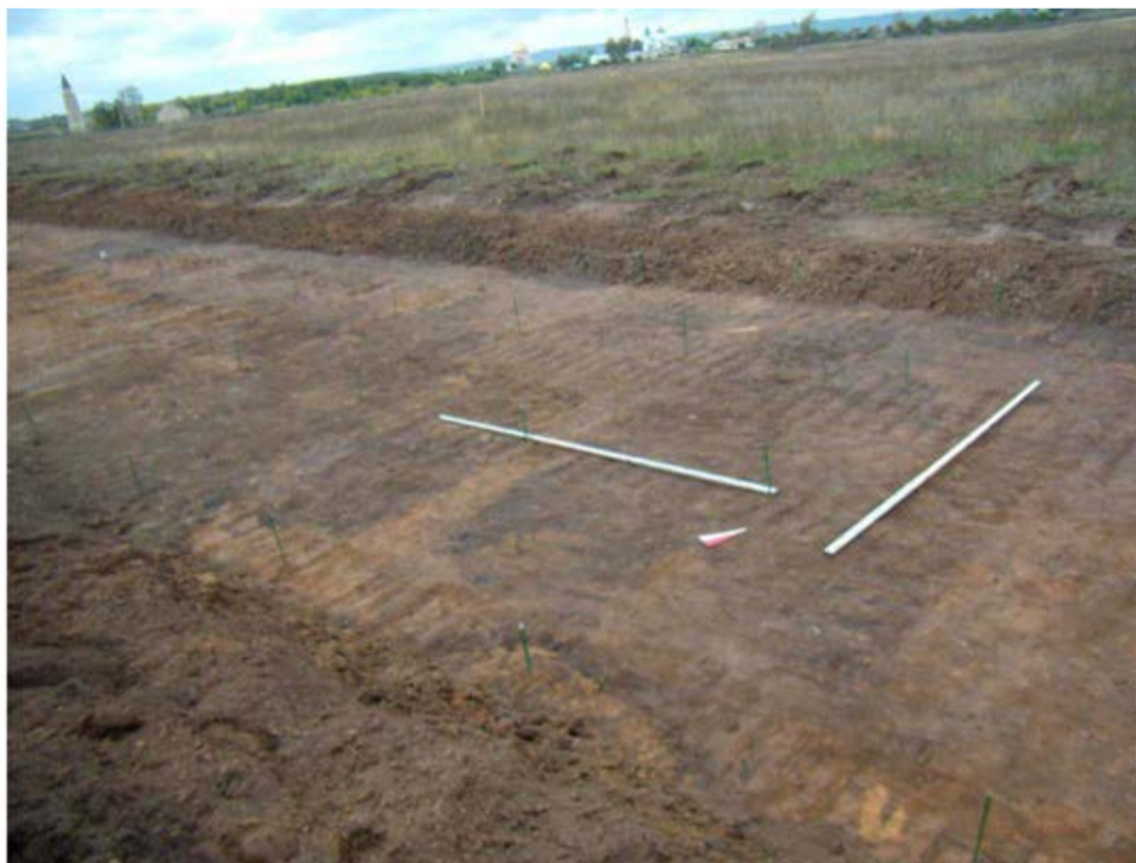
Наблюдения при строительстве асфальтовой дороги на месте исторических дорог
