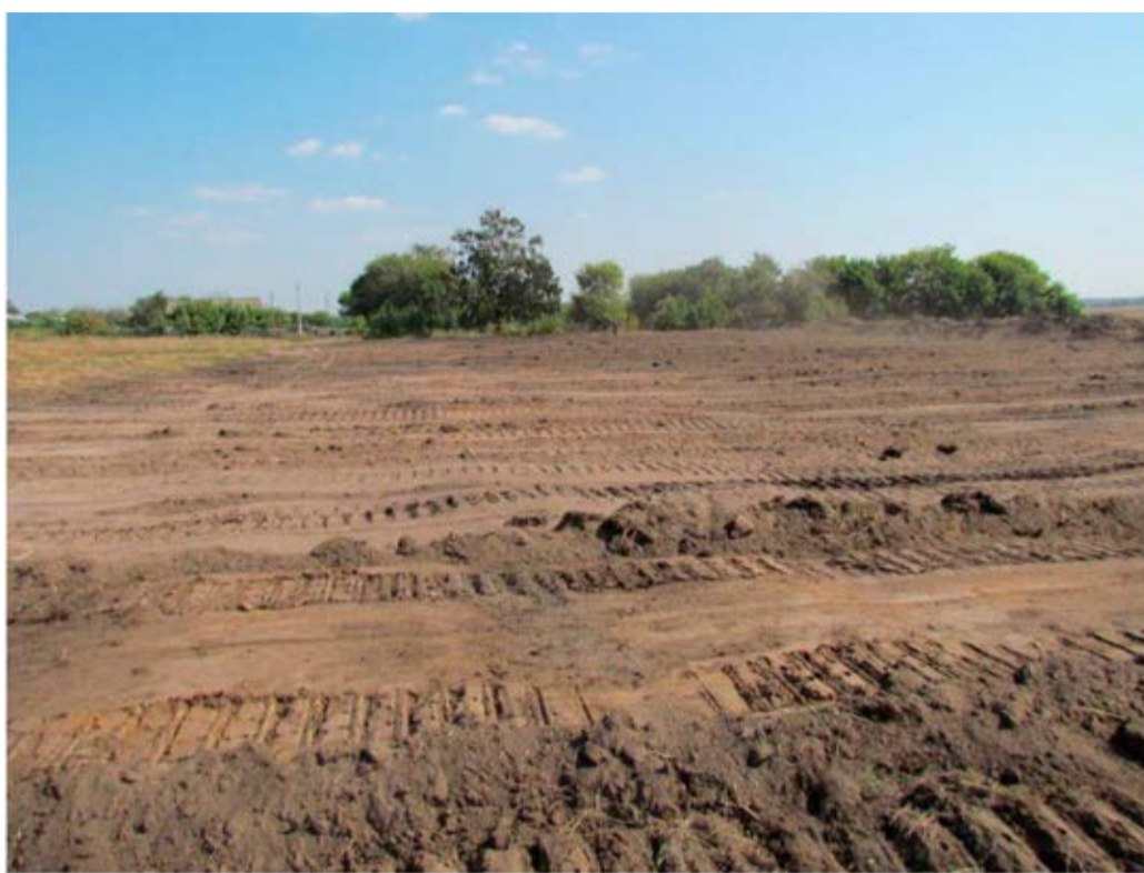
Срезка грунта на месте предстоящего строительства автостоянки.
