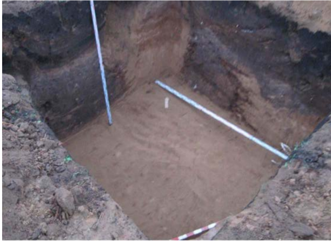
Водоканал. Шурф №1 в районе котельной речного порта.
