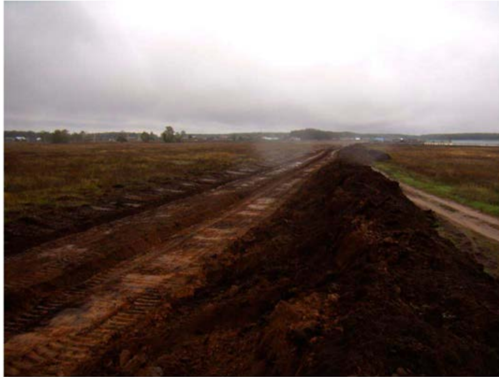
Наблюдения при строительстве асфальтовой дороги на месте исторических дорог Observations during asphalt road construction on the site of historic roads
