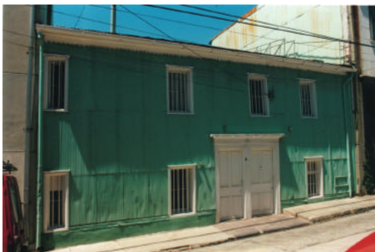
Materialidad: Forrado en planchas de Zinc
