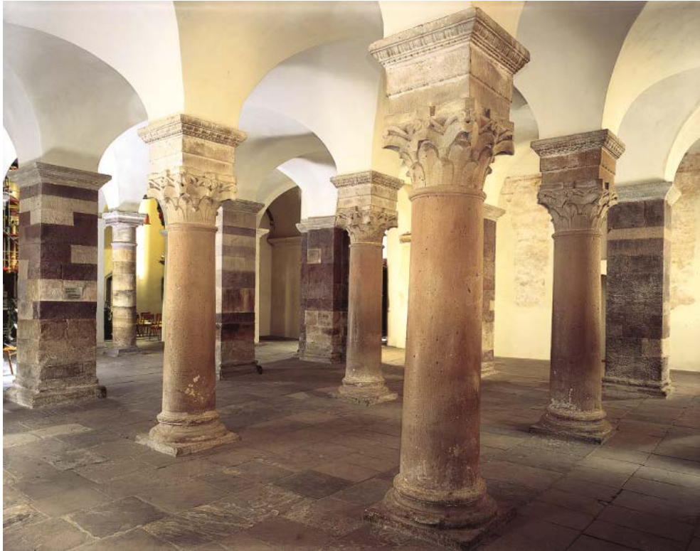
Le Westwerk, rez-de-chaussée
