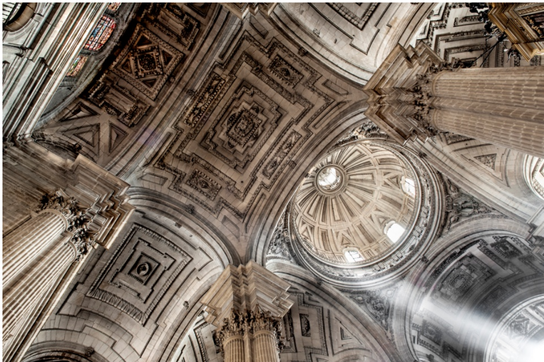
Voûtes et coupole du transept
