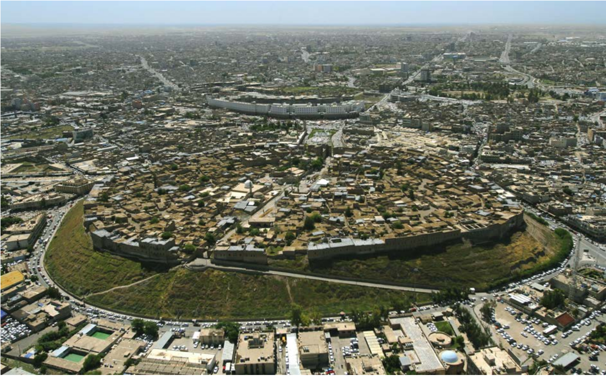
Vue aérienne de la citadelle
