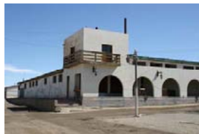
Pulpería, esquina Sur, actualmente en segundo piso está la Oficina Técnica de la CMS.
