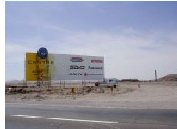
Letrero Caminero. Afecta la visión del Bien | Road signpost. It's a negative impact over site view Eugenio Correa, 2003
