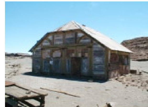
Bomba de agua, Oficina Humberstone | Water pump, Humberstone Works Genaro Cuadros, 2001
