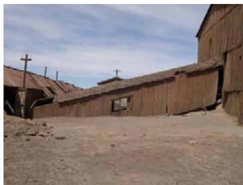
Detalle de la cinta transportadora que comunica los molinos primarios con el molino secundario
