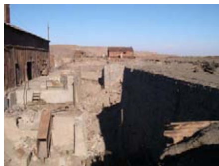
Vista de la molienda, se conserva lo que es de piedra y hormigón.
