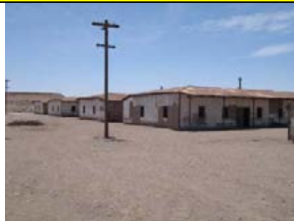
Vista general del sector
