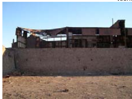
Atrás de los muros de la bodega sin techo, está el galpón
