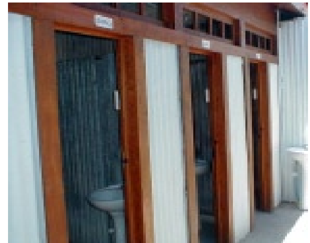
Los baños una vez terminados The bathrooms on completion of works Eugenio Correa, noviembre | november 2003
