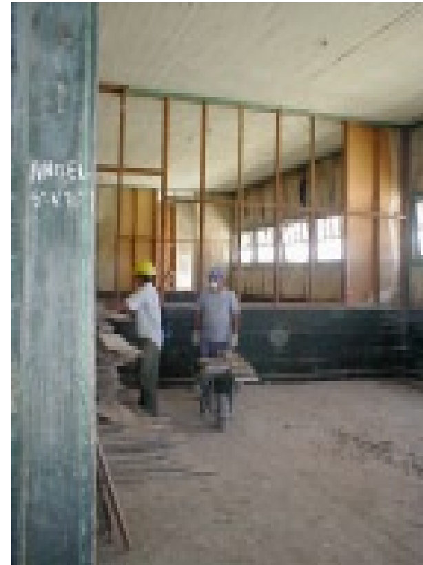
Obras en una de las salas de la Escuela E-35. Pulido de maderas y reposición de tabiques rotos Working in one of the classrooms of the E-35 school. Polishing wood and replacing broken walls Eugenio Correa, enero | January 2003
