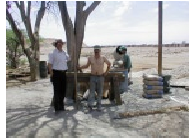
Hombres trabajando con el supervisor | Men at work with the site supervisor Eugenio Correa, 2003
