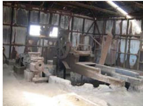
Interior, donde se mantienen piezas de las bombas, se percibe el foso de 7 m de profundidad
