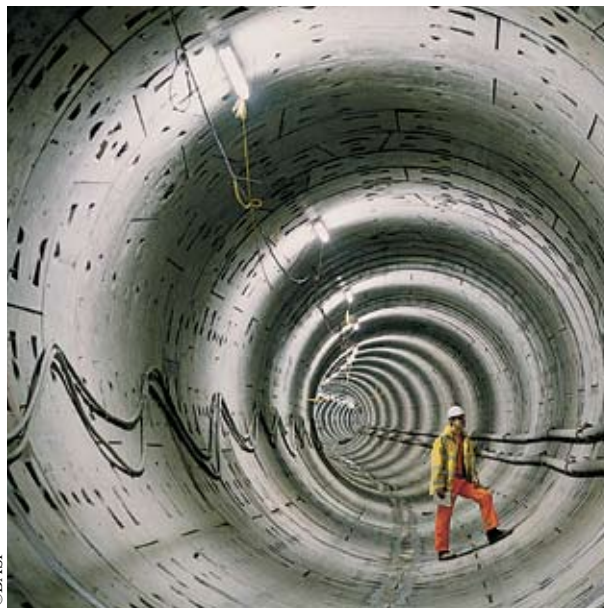
©BASF L'application au pistolet d'une membrane conçue par BASF sur la paroi intérieure d'un tunnel en construction, au Royaume-Uni, réduit la quantité de béton nécessaire et économise ainsi des millions d'euros en frais de construction tout en réduisant la quantité de CO 2 émis par la fabrication du ciment.
